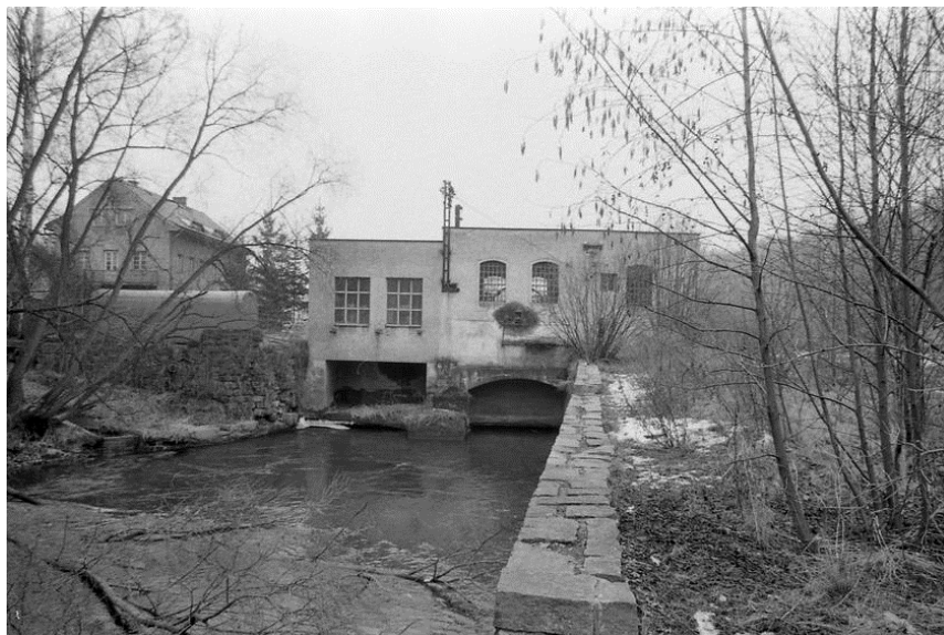
Obr. 7: Stav vodního díla po předání z rukou Středočeské energetiky (zdroj: fotodokumentace majitele )
