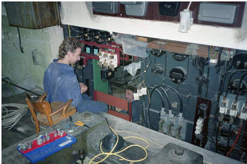
Obr. 11: Práce na nové elektroinstalaci (zdroj: fotodokumentace majitele)
