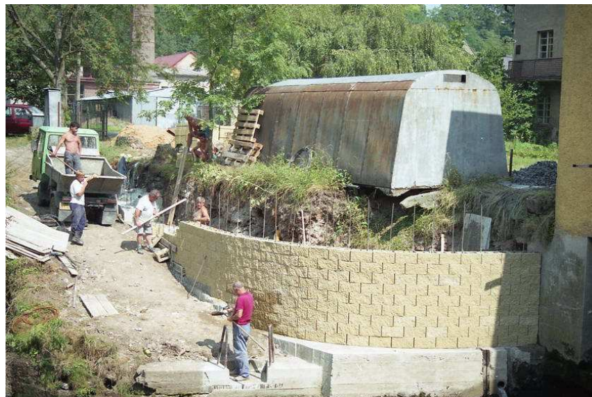
Obr. 13: Stavba nové opěrné zdi (zdroj: fotodokumentace majitele )
