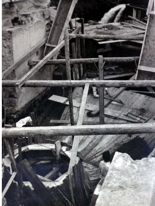
Obr. 6: Výstavba nové Francisovy turbíny (zdroj: fotodokumentace majitele)
