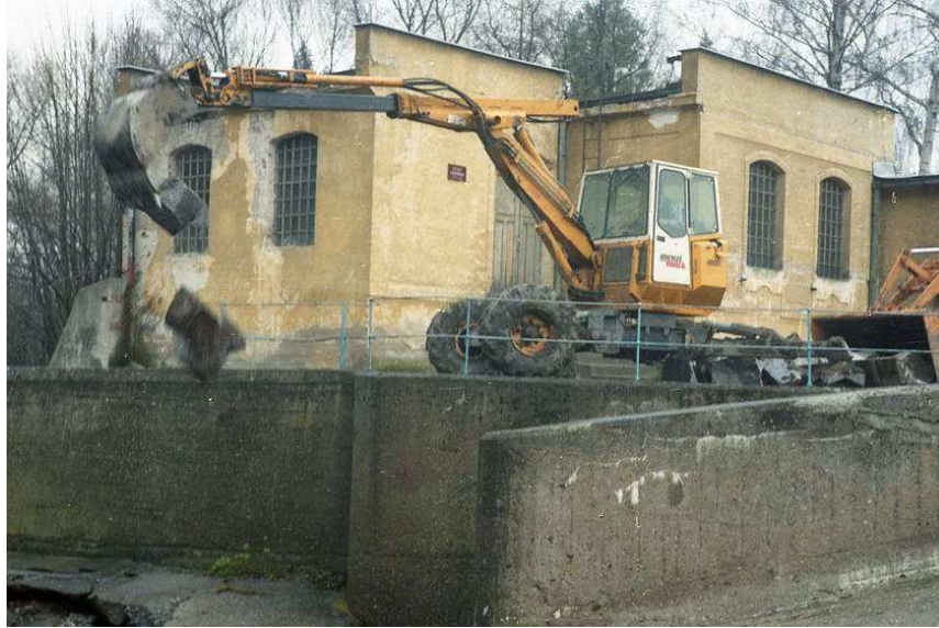
Obr. 10: Zastavení podemílání těžkým záhozem (zdroj: fotodokumentace majitele)
