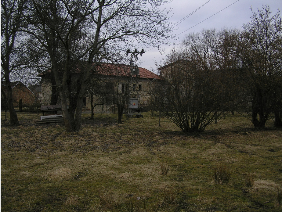
obrázek 5.2.4-5 Budova MVE s transformátorem a sloupem vedení [4]
