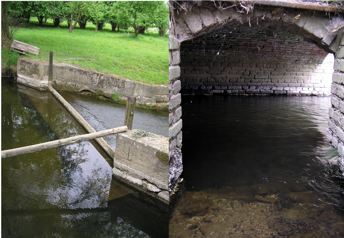
obrázek 5.2.2-2 jez do ramene náhonu a odpadní kanál [4]
