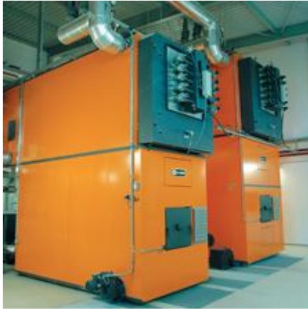
Obr. 4. Kotle Schmid typu UTZR[7]
