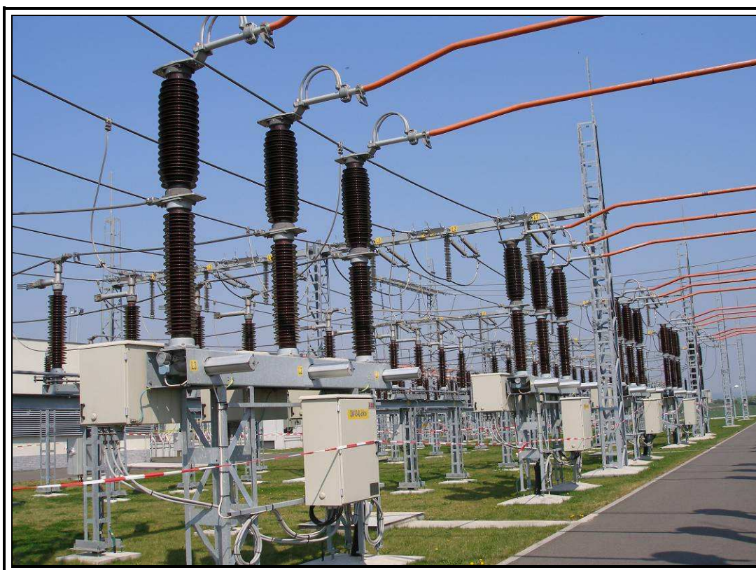
Obr. 1 – Vypínače 110 kV v provedení AIS
