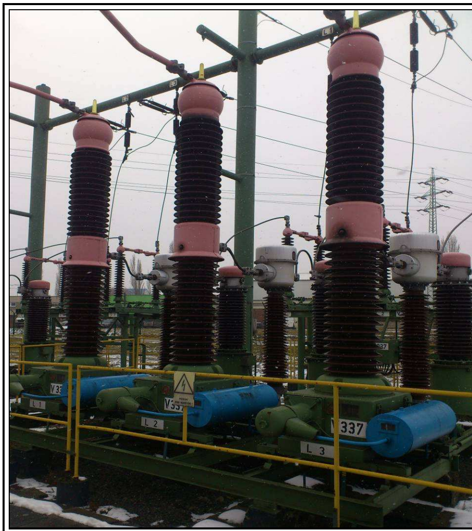
Obr. 6 – Máloolejový vypínač VVN
