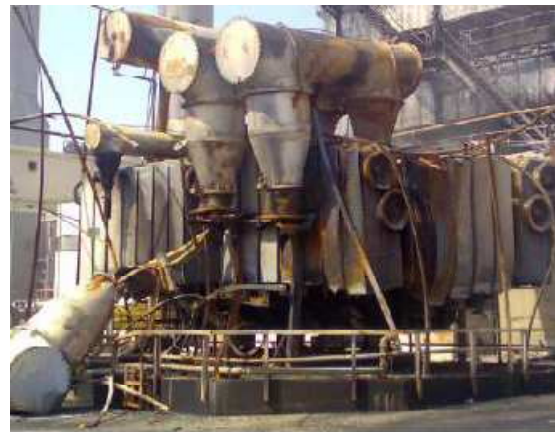
Obr. 7 Zničený blokový transformátor elektrárny [27]
