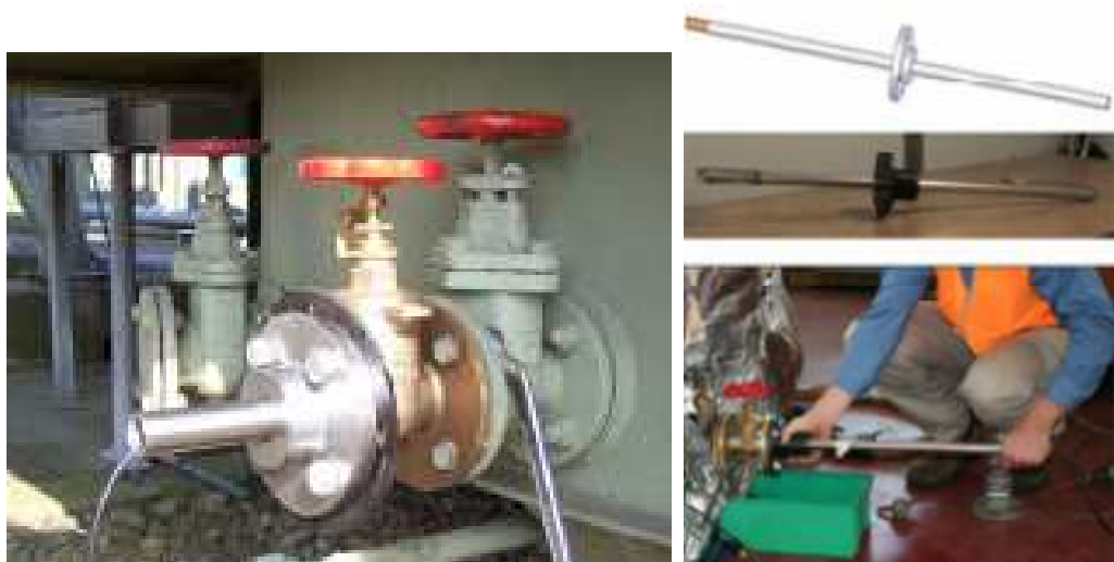
Obr. 18 Ukázka instalace UHF antény skrze olejový ventil [33], [32]
