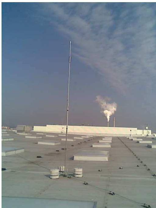
Obr. 19 Aktivní jímač – Pulzar ESE na obchodním centru v Plzni
