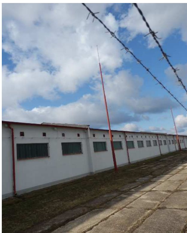
Obr. 34 Stožárový typ hromosvodu na skladu pohonných hmot v Plzni
