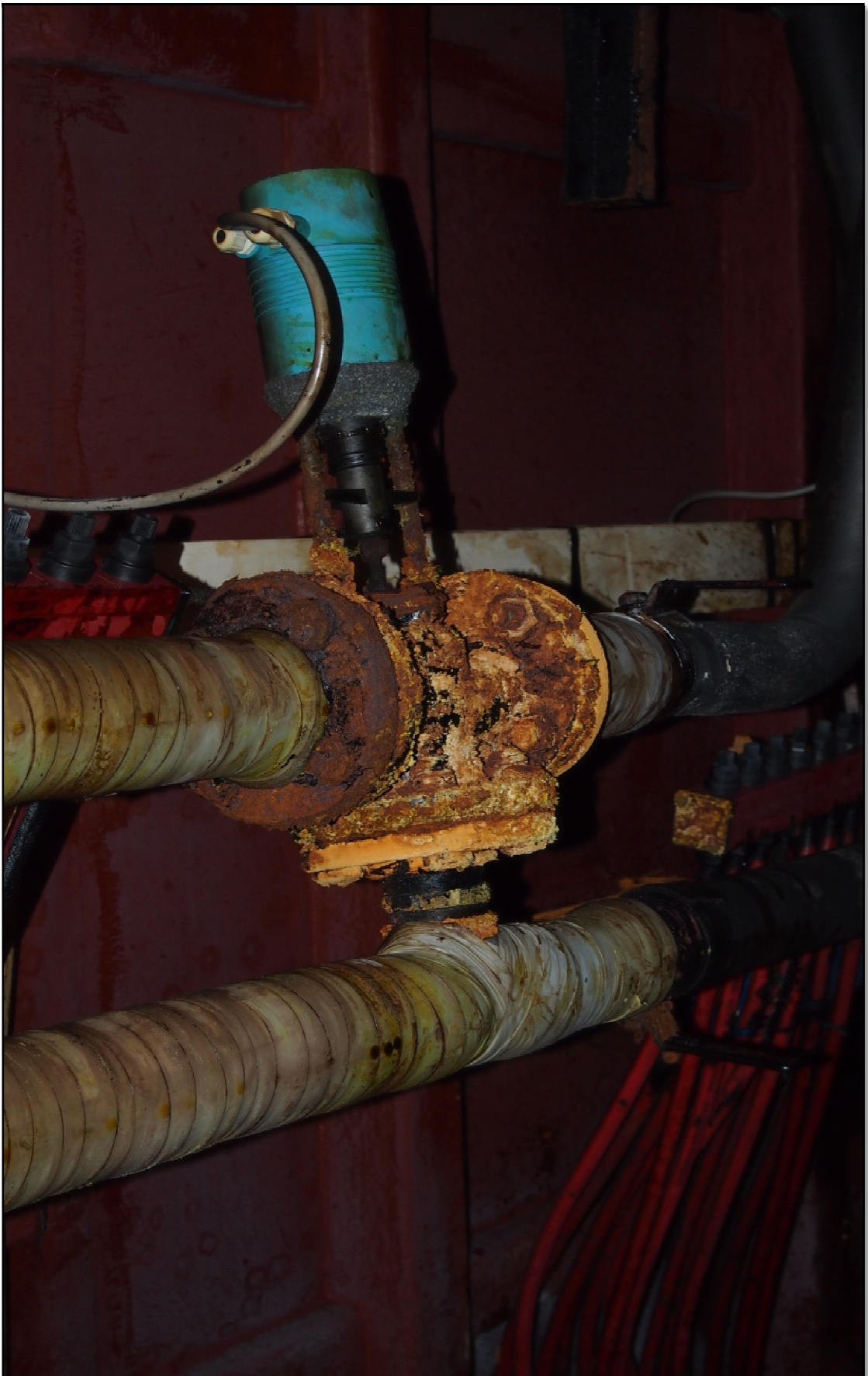
Příloha č. 3: Příruba čerpadla
