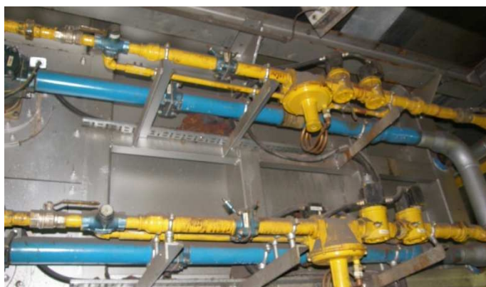
Obr. č. 11: Regulace plynu pro vytápění zinkovací pece [8]
