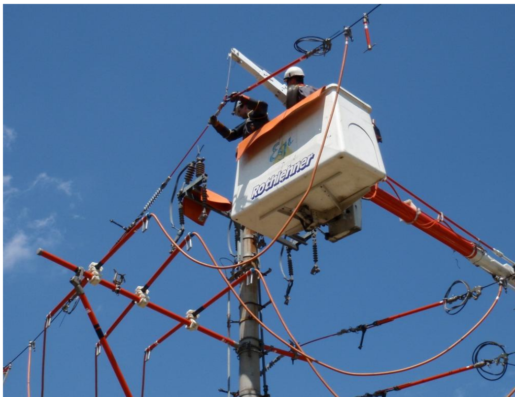
Obrázek 4: Výměna úsečniku metodou PPN
