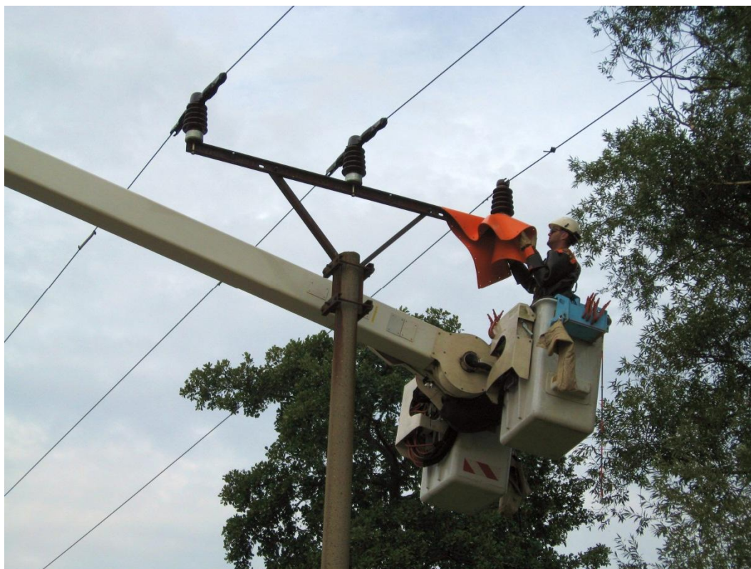
Obrázek 5: Montáž ochran proti úrazu ptactva PPN - metodou v dotyku
