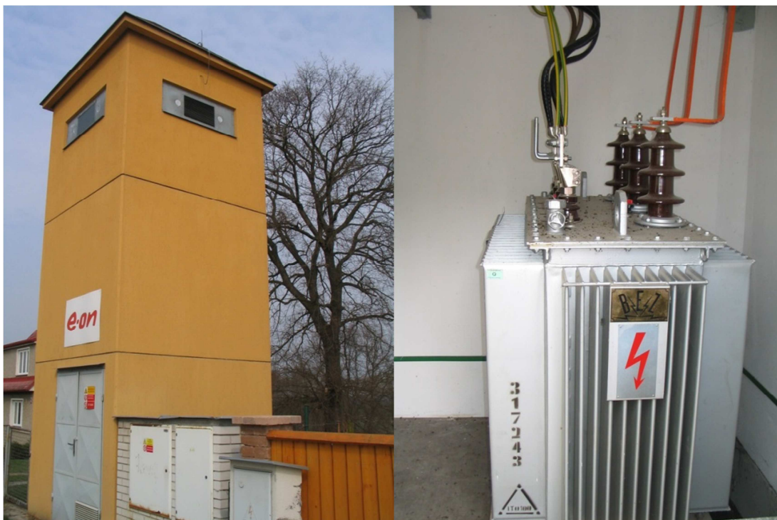
Obr. 3.2 Věžová TS s jedním DTR [19]
