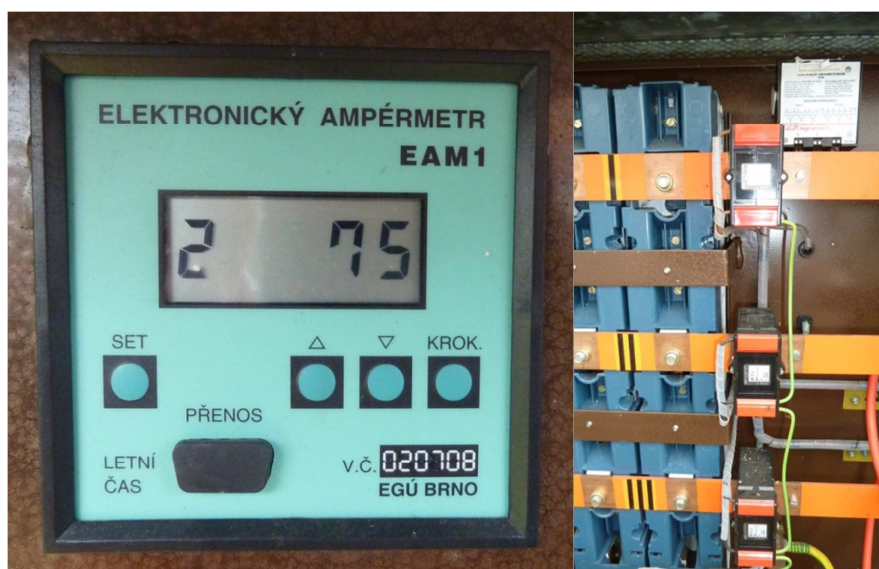
Obr. 4.4 Elektronický ampérmetr EAM1 a jeho osazení [19]
