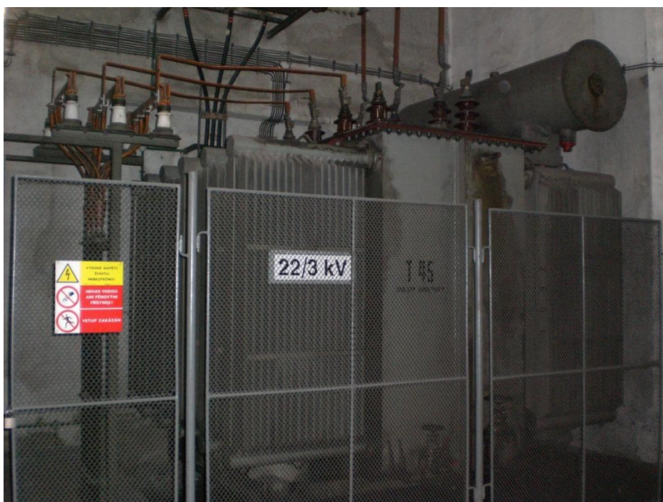
Transformátor 22/3 kV
