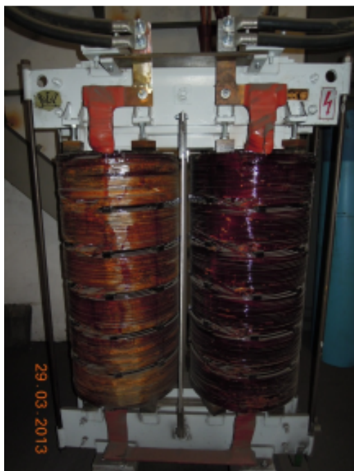
Obr. 21 Symetrizační tlumivka
