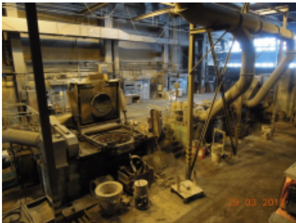
Obr. 24 Celkový pohled na ind. kelímkové pece
