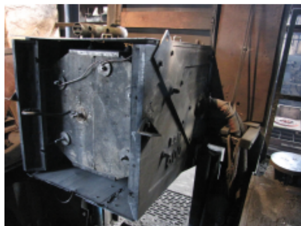
Obr. 18 Spodní pohled, uzemnění pece
