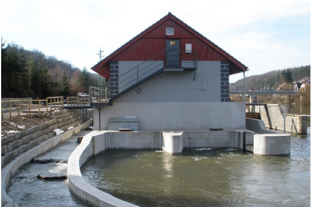
Obr. 4.4 Výtok z MVE s rybím přechodem [31]
