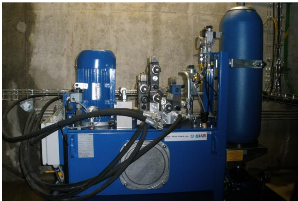
Obr. 4.7 Zařízení pro ovládání rozváděcích lopatek [31]
