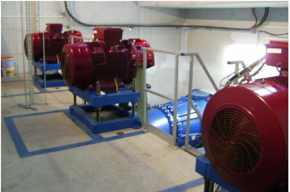
Obr. 4.12 Umístění generátorů v MVE Hýskov [31]
