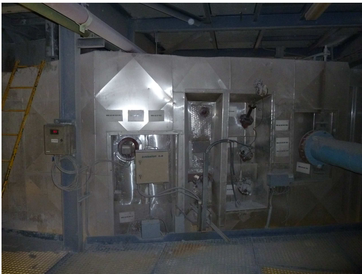
Obr. 11: Analyzátor plynů s ukazatelem přebytku kyslíku ve spalinách.
