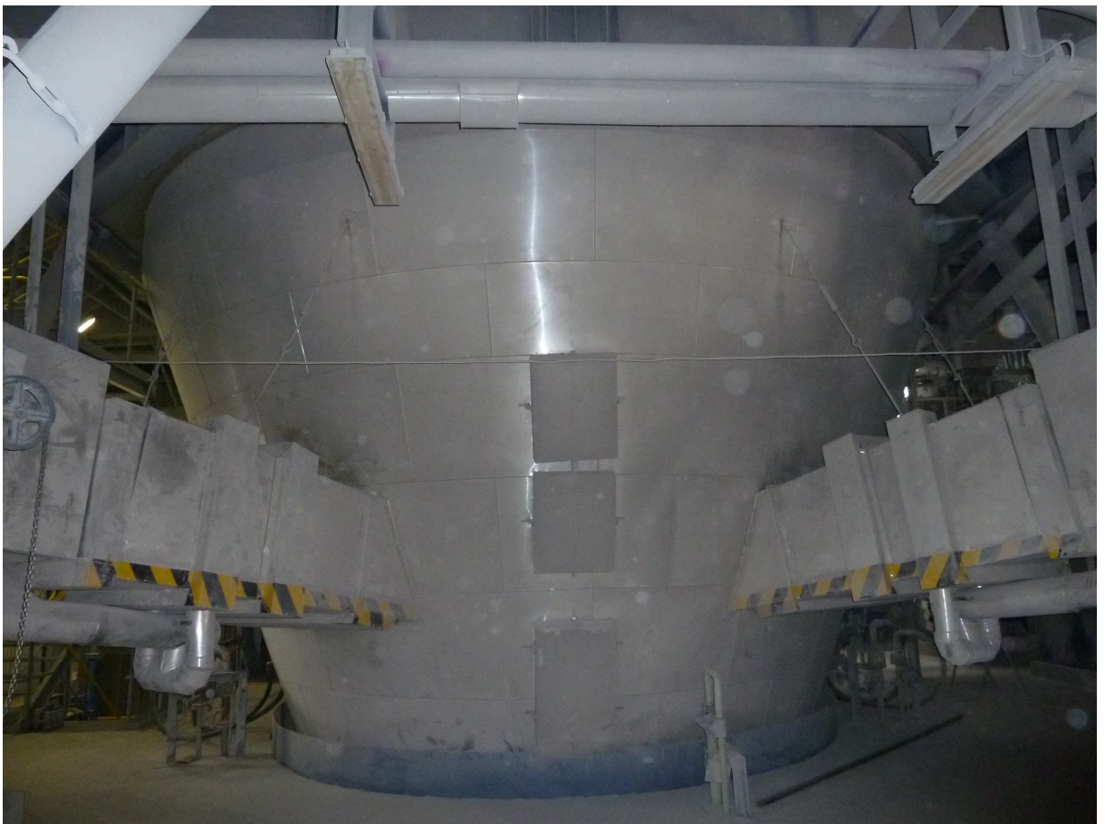
Obr. 6: Zaústění horní cesty recirkulace produktu do absorberu.
