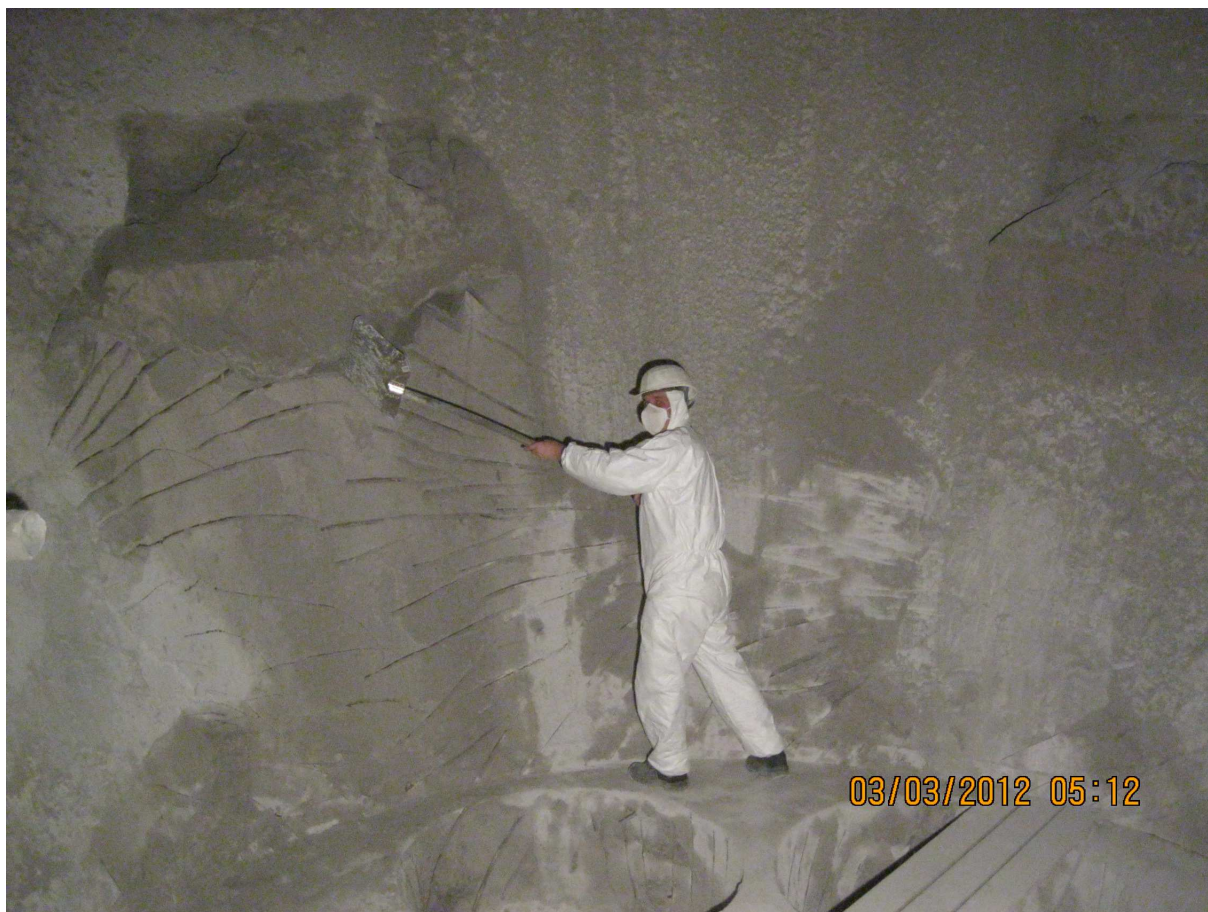
Obr. 7: Údržba absorbéru nad Venturiho tryskami během jarní odstávky 2012.
