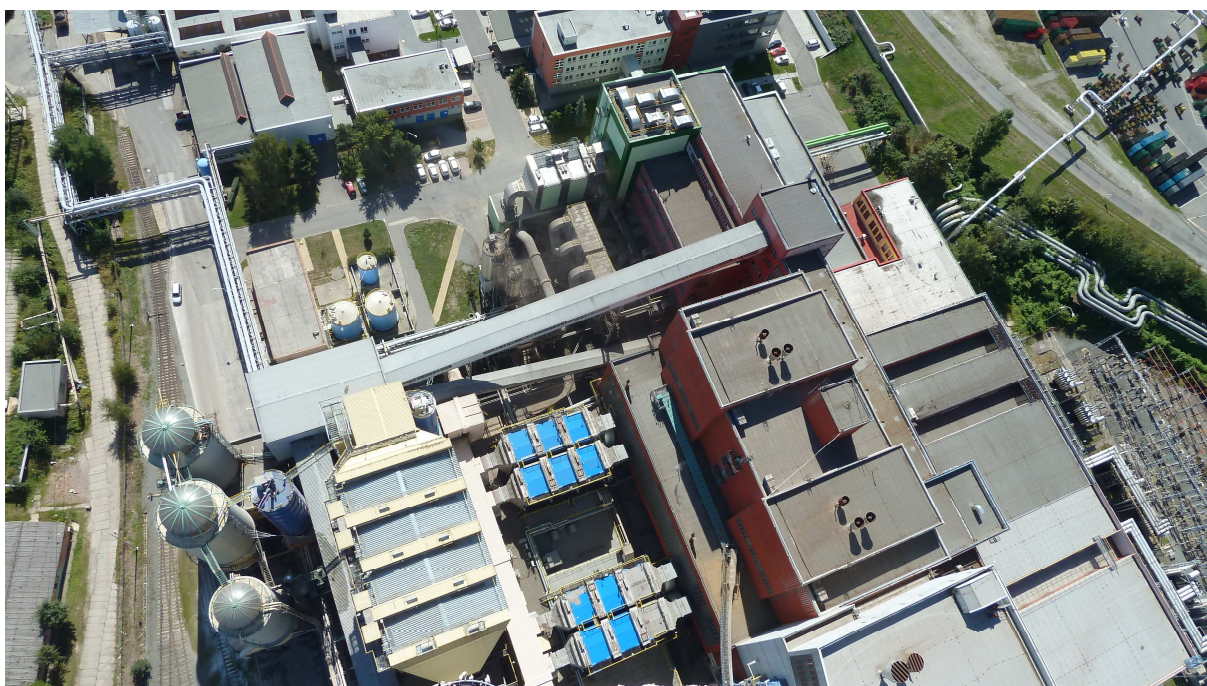
Obr. 5: Pohled z komínu. Budova odsiřování se nachází v dolní levé části snímku.
