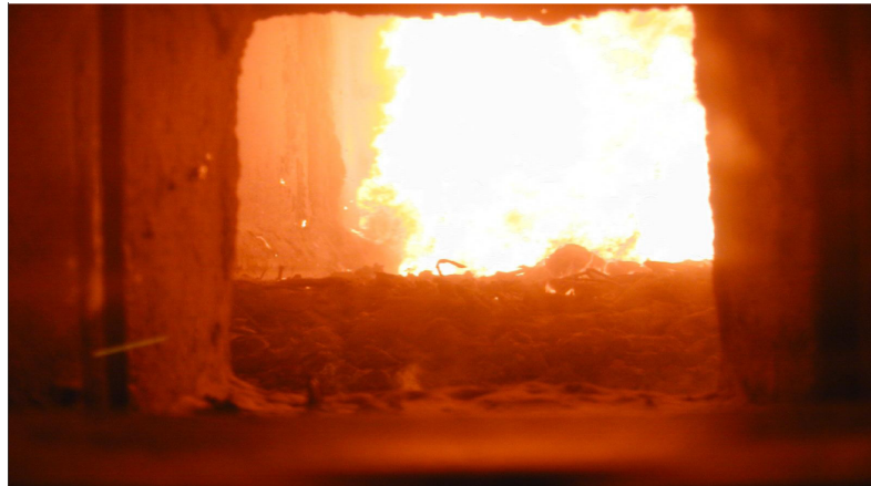
Obr. č. 20 Pohled do spalovací komory ve spalovně ZMS Schwandorf [23]
