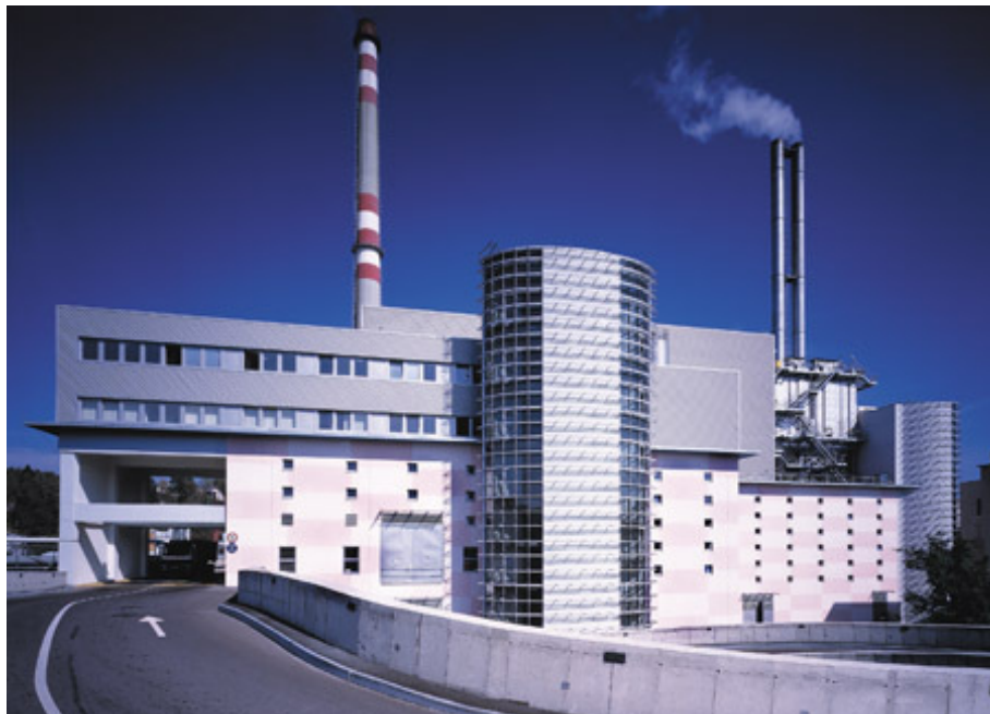
Obr. č. 11 ZEVO Termizo Liberec [38]
