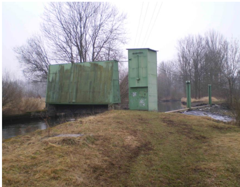
Obrázek 3 Celkový pohled na vtok a jez
