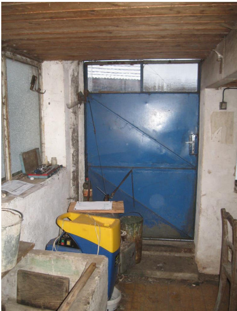
Obrázek 26 Detail vstupu MVE Metaz před montáží vzdáleného dohledu
