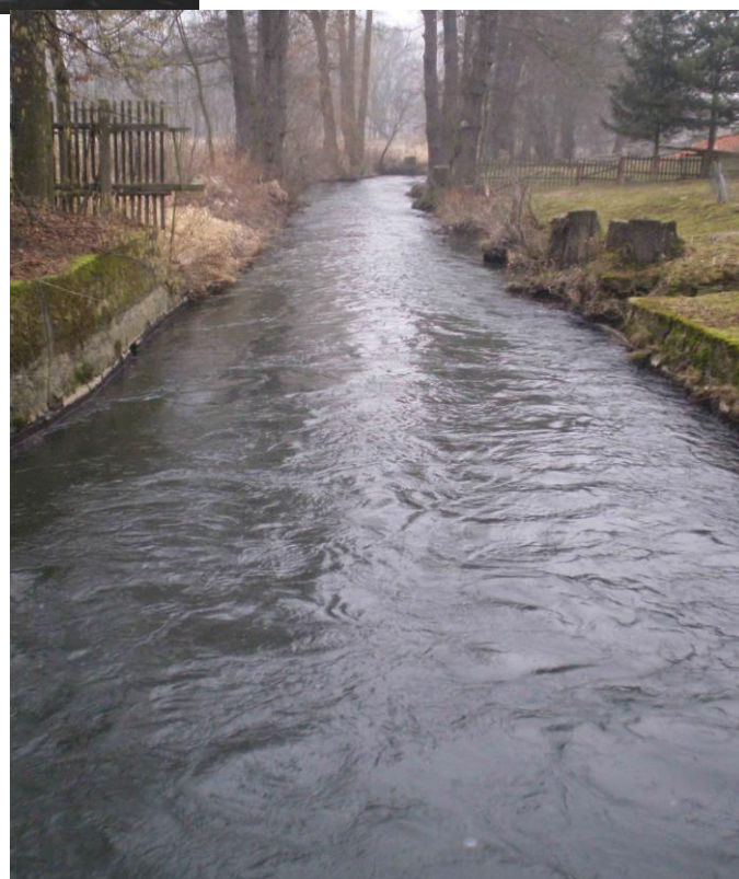
Obrázek 21 Odpadní kanál -Pohled z lávky pro pěší (viz obr.20)
