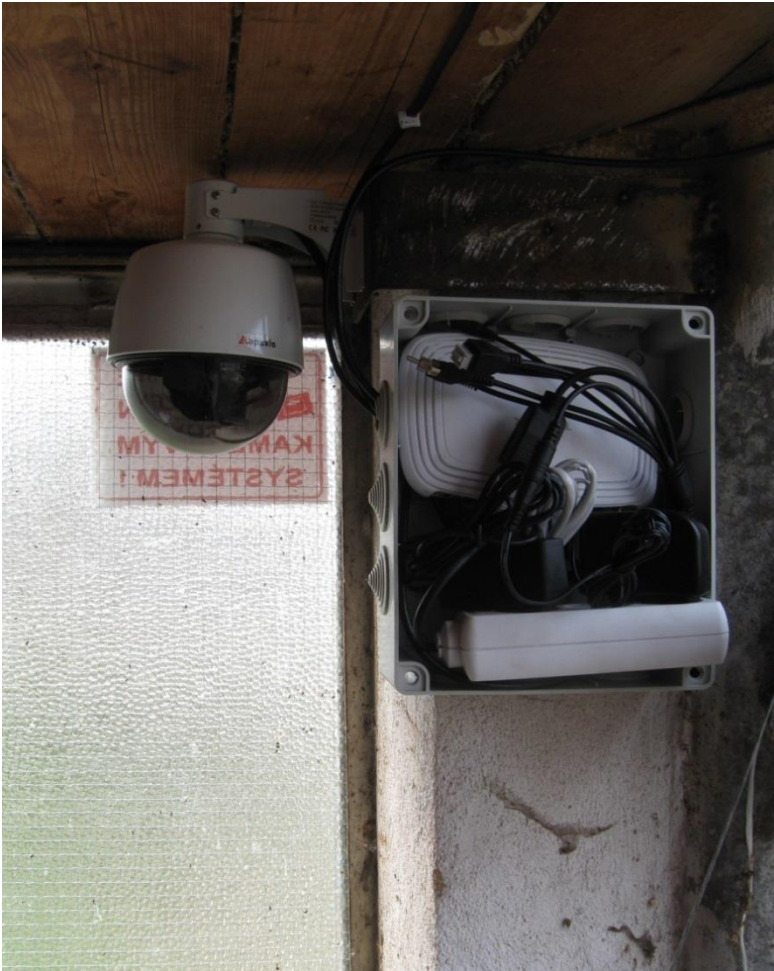
Obrázek 40 Elektroinstalační krabice IP kamery
