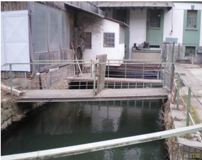
Obrázek 6 Detail vtoků MVE
