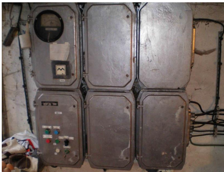
Obrázek 9 Rozvaděčové skříňě MVE Metaz
