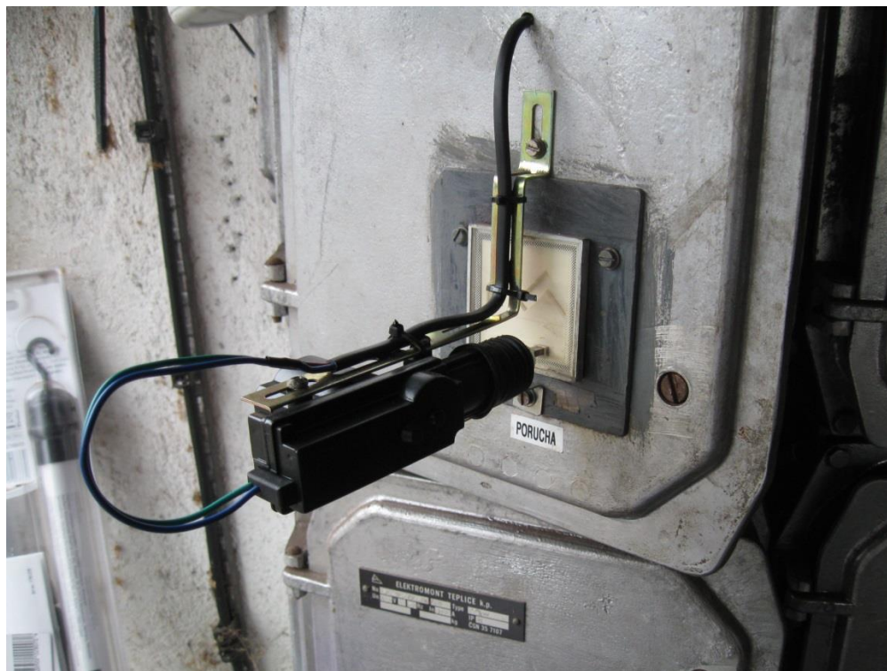
Obrázek 36 Detail řešení aretace poruchového relé přes servomotorek
