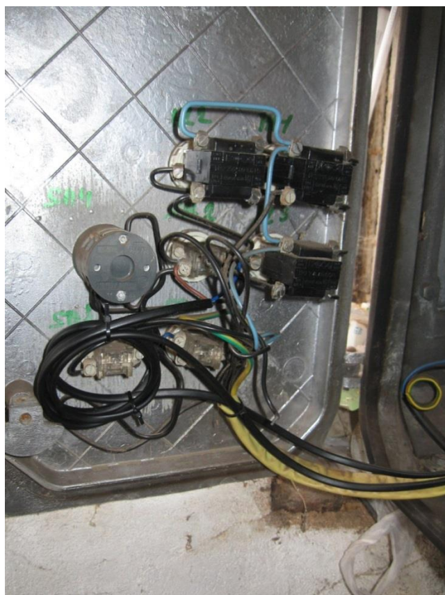
Obrázek 37 Detail zapojení spínacích a rozpínacích kontaktů do stávajícího obvodu
