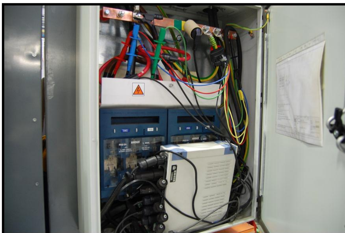
Nová TS: 2 připojení ENA 330 U, I svorky v R2 přímo u bodové svářečky
