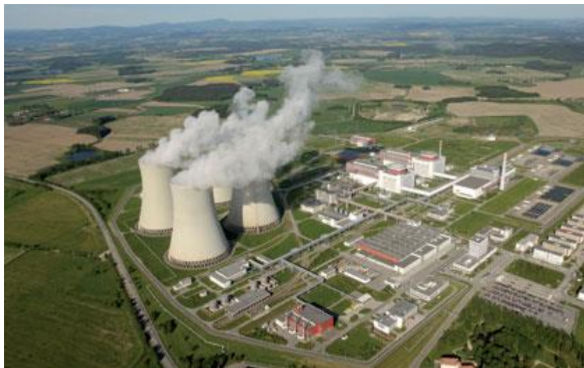
Obr. 25 - Jaderná elektrárna Temelín 49
