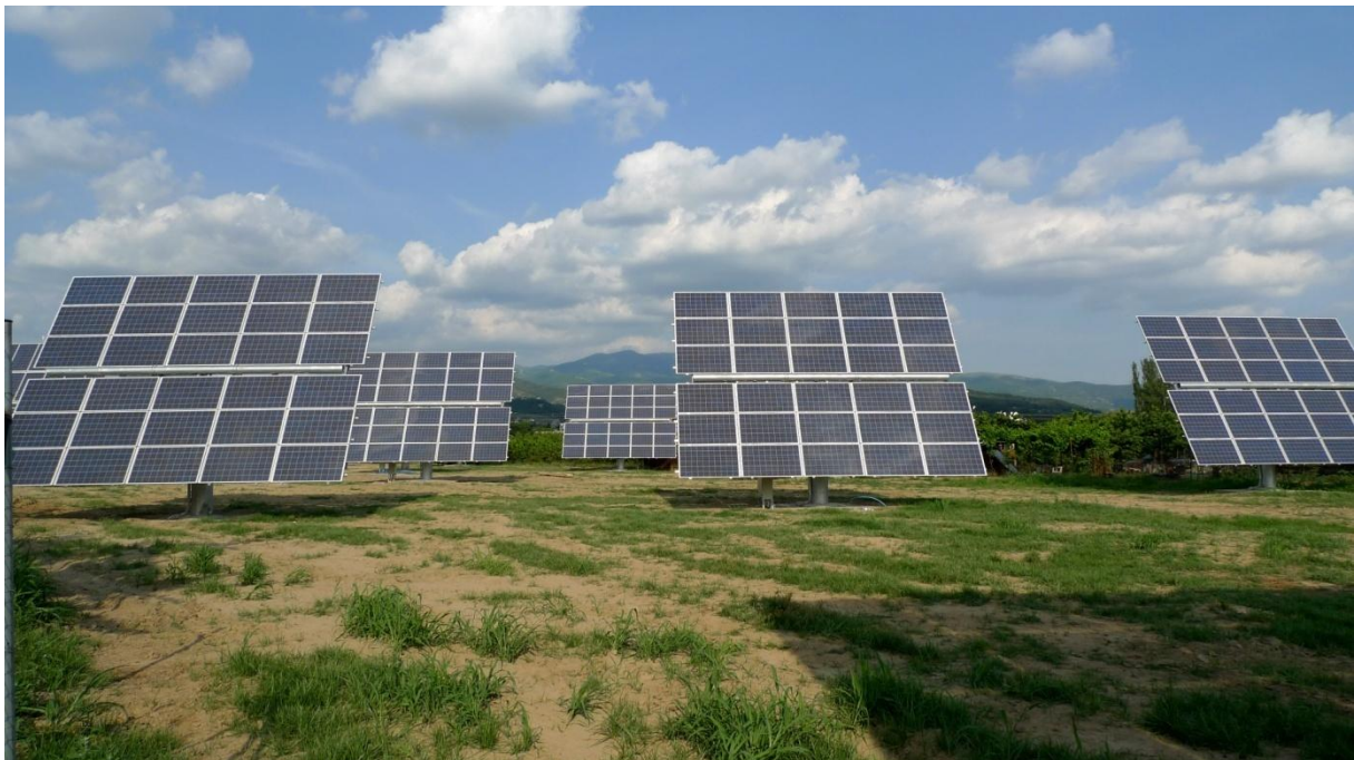
Příloha 8 Umístění PV panelu v terénu [14]
