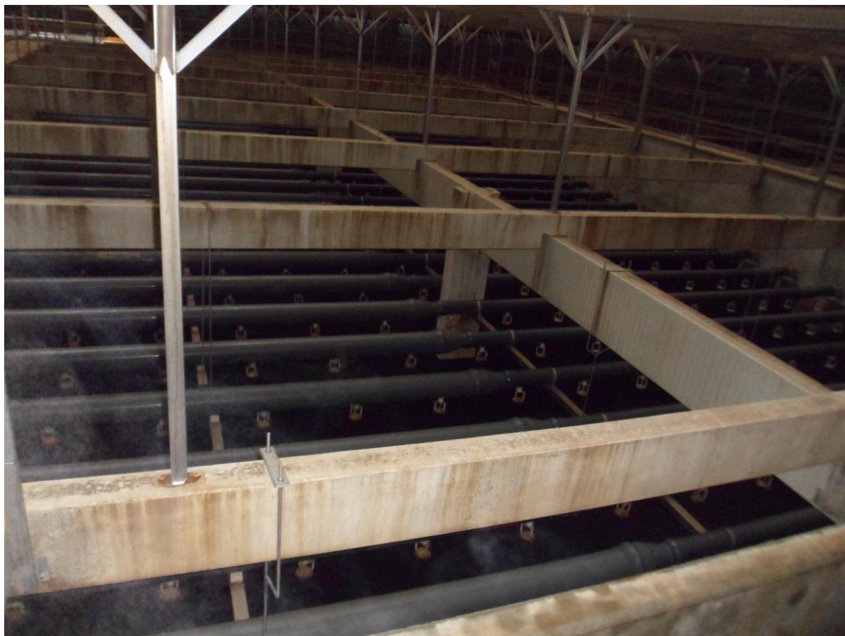
Příloha 8 Pohled uvnitř věže, elektrárna Tušimice II [14]
