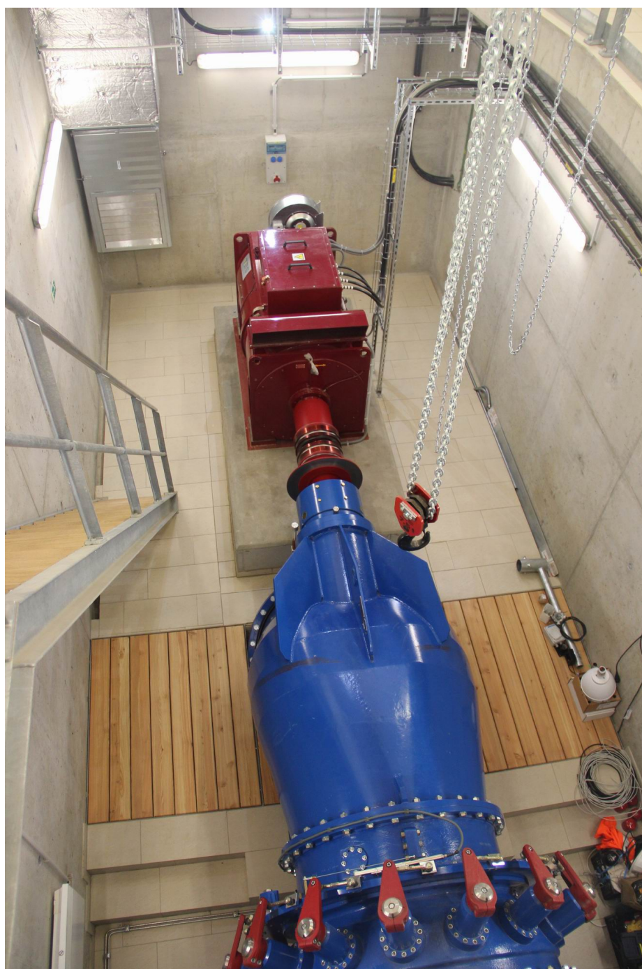
Obr. 3. Turbína s generátorem
