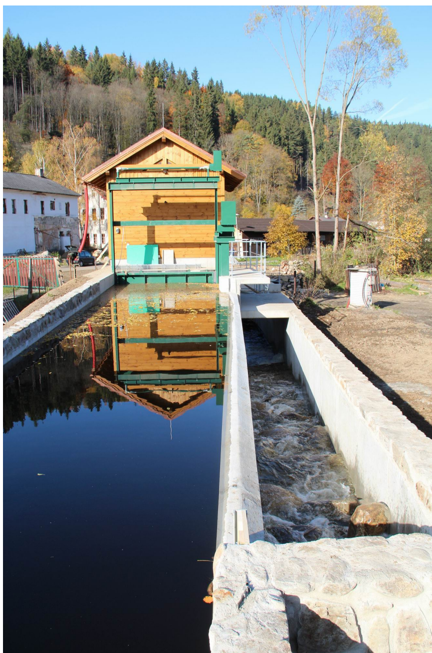
Obr. 5. Objekt česlovny s česlemi a rybí přechod
