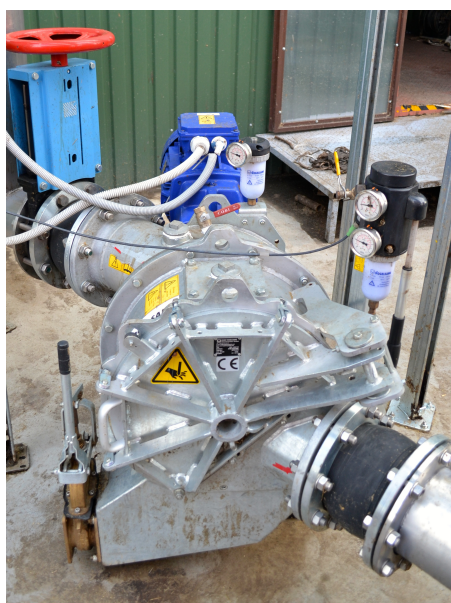
Obrázek č. 8 Macerátor BPS Vintířov [Foto Pavel Partyngl]
