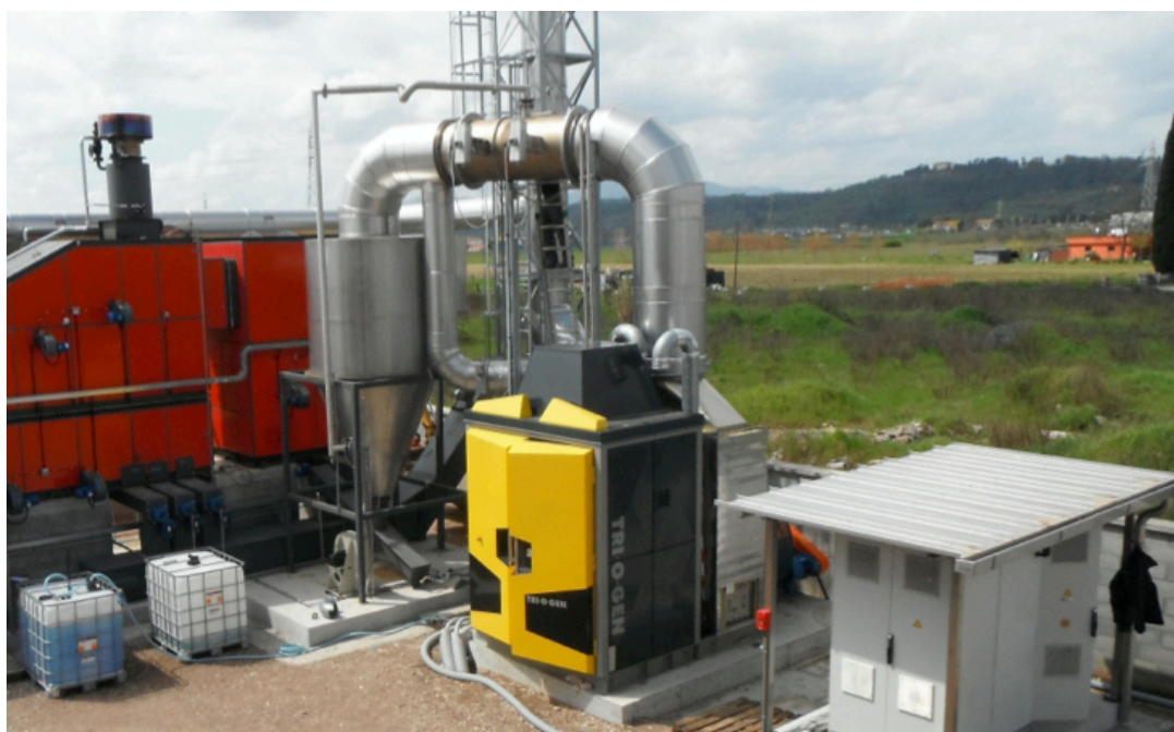
Obrázek č. 22 ORC zařízení [Tri-O-Gen WB-1 Vario]
