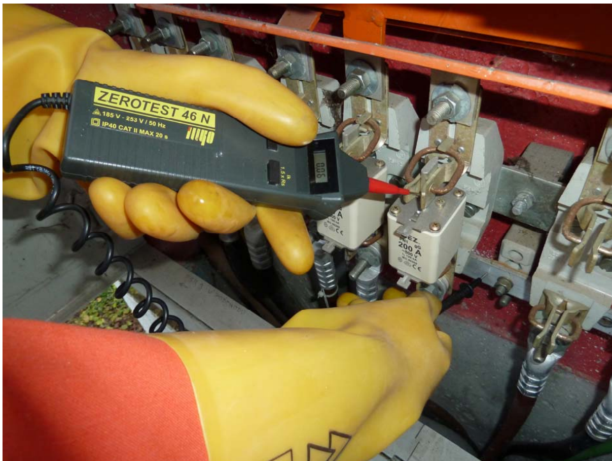
Obrázek 3.1: Měření jednofázové zkratové impedance smyčky Z_{L-N} [24]
