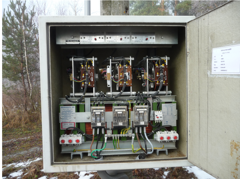
Obr. 4.1 Regulátor nn/nn Schmachtl 100 kVA
