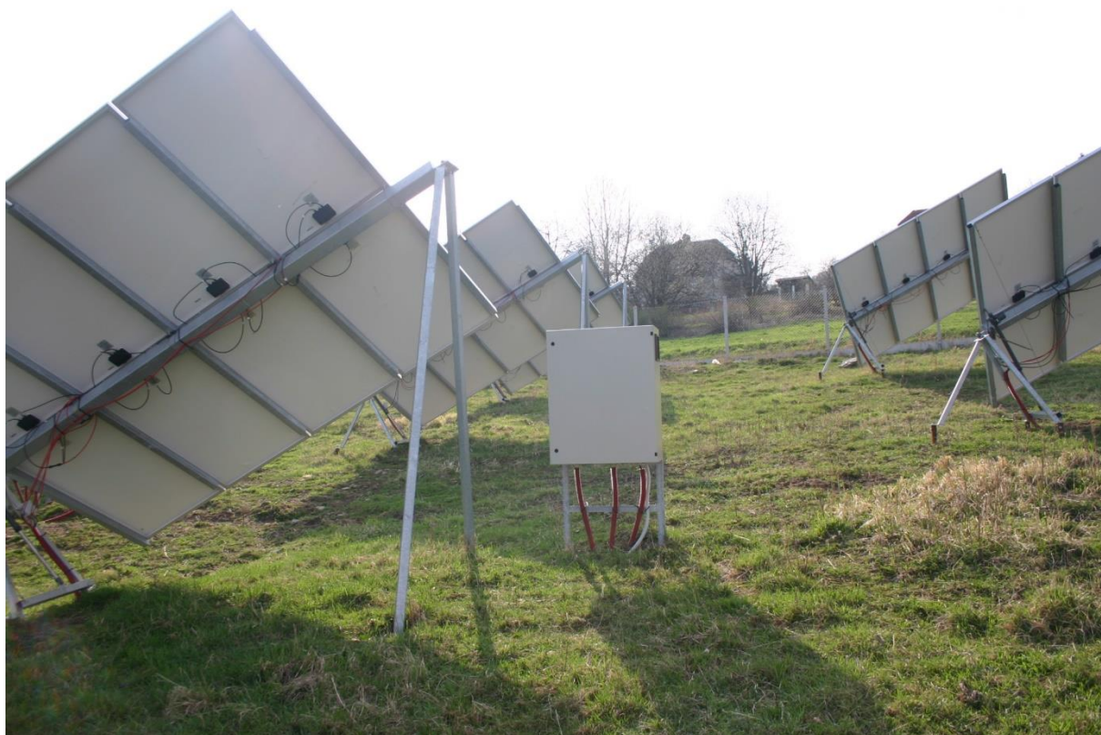
Obr. č. 13 Umístění střídačů přímo u panelů.
