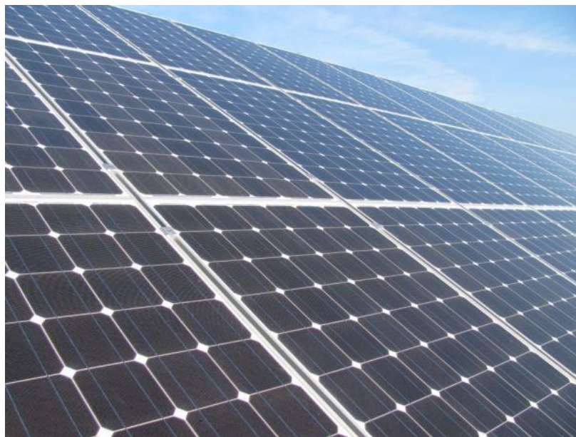
Obr. č. 2 Ukázka monokrystalického panelu se svým typickým zabarvením [18]
