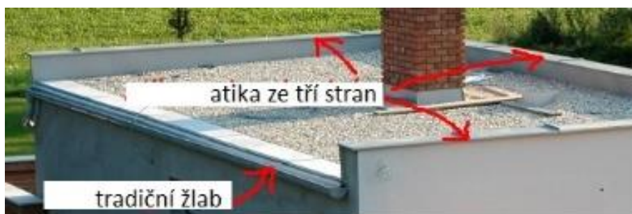
obr 6.03 Odvodnění – Tradiční žlab
