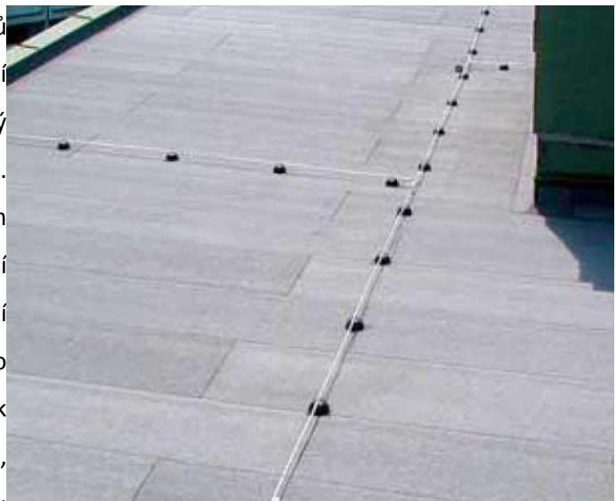
Obr. 2.2 Provedení povlakové krytiny z SBS modifikovaného pásu
