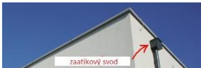
obr 6.02 Odvodnění - Zaatkový svod
