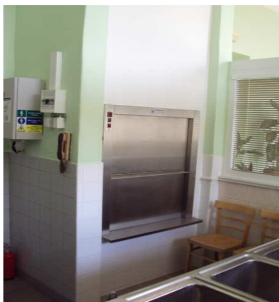
Obr.č. 5 - Jídelní výtah
