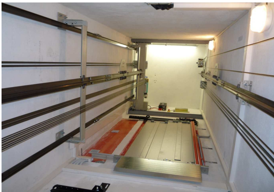
Obr.č. 10 - Šachta výtahu
