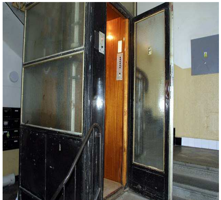
Obr.č. 2 - Starý typ výtahu
