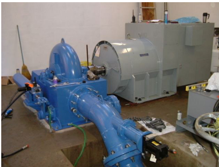
Obr. 14 Peltonova turbína s jednou tryskou v elektrárně Malibu [13]
