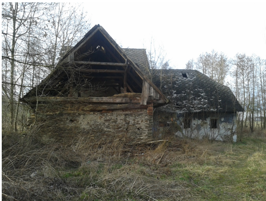
Obrázek 2 – Budova starého mlýna v Postřekově
