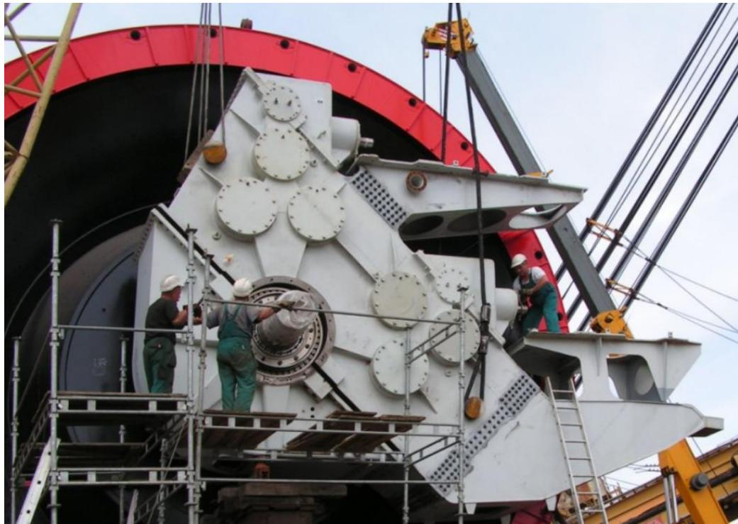
Obr. 2-2 Instalace převodovky pohonu kolesa korečkového velkorypadla
