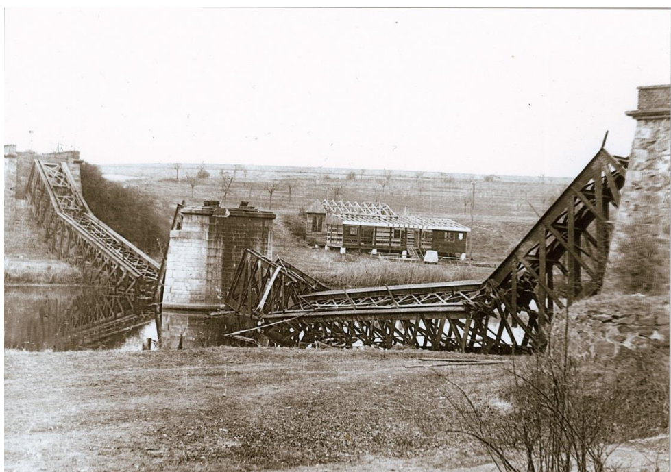
Příloha 6, Obr. 19: Pozůstalé mostní pilíře přes řeku Radbuzu, kudy vedla vlečka na přelomu 18. a 19. století. Zdroj: vlastní sbírka fotografií pana Celera
