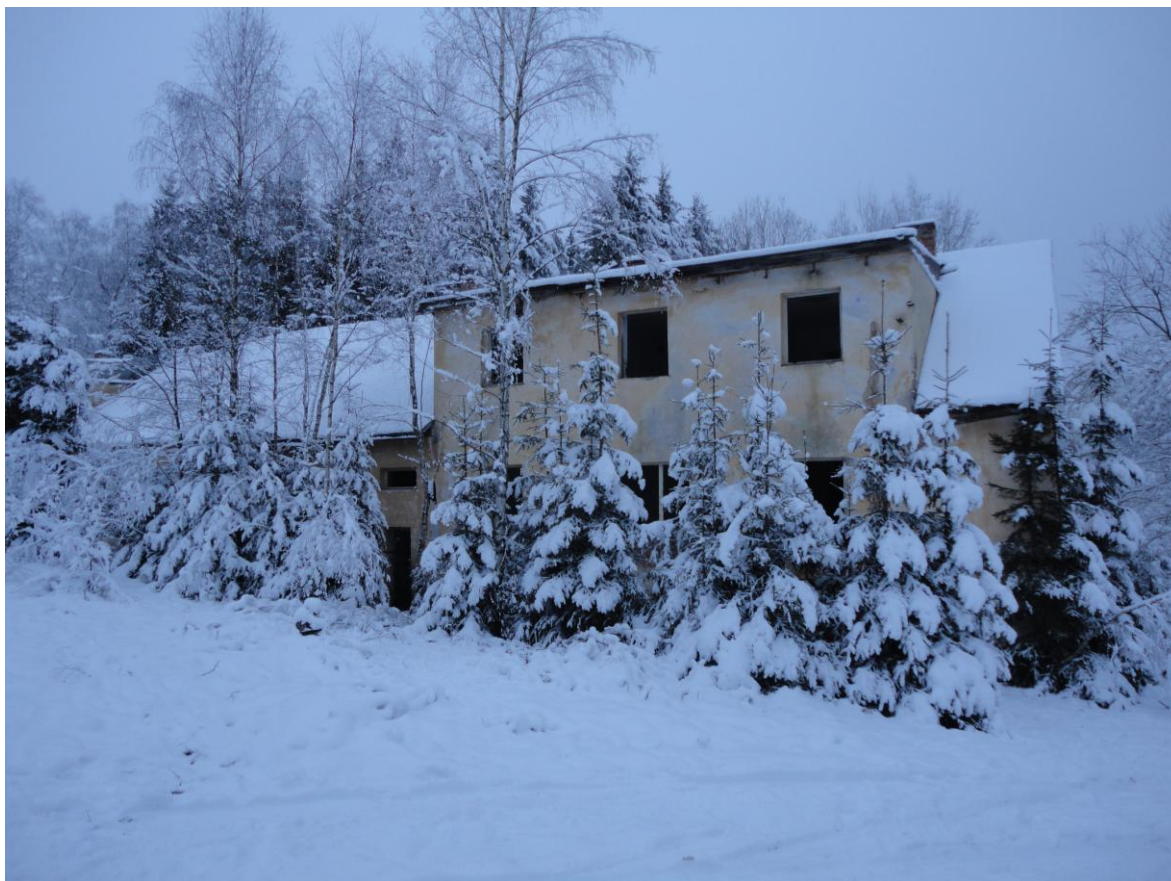
Obr. 45: Budova bývalé pohraniční stráže v zaniklé obci Hraničná, foto: P.Viová
