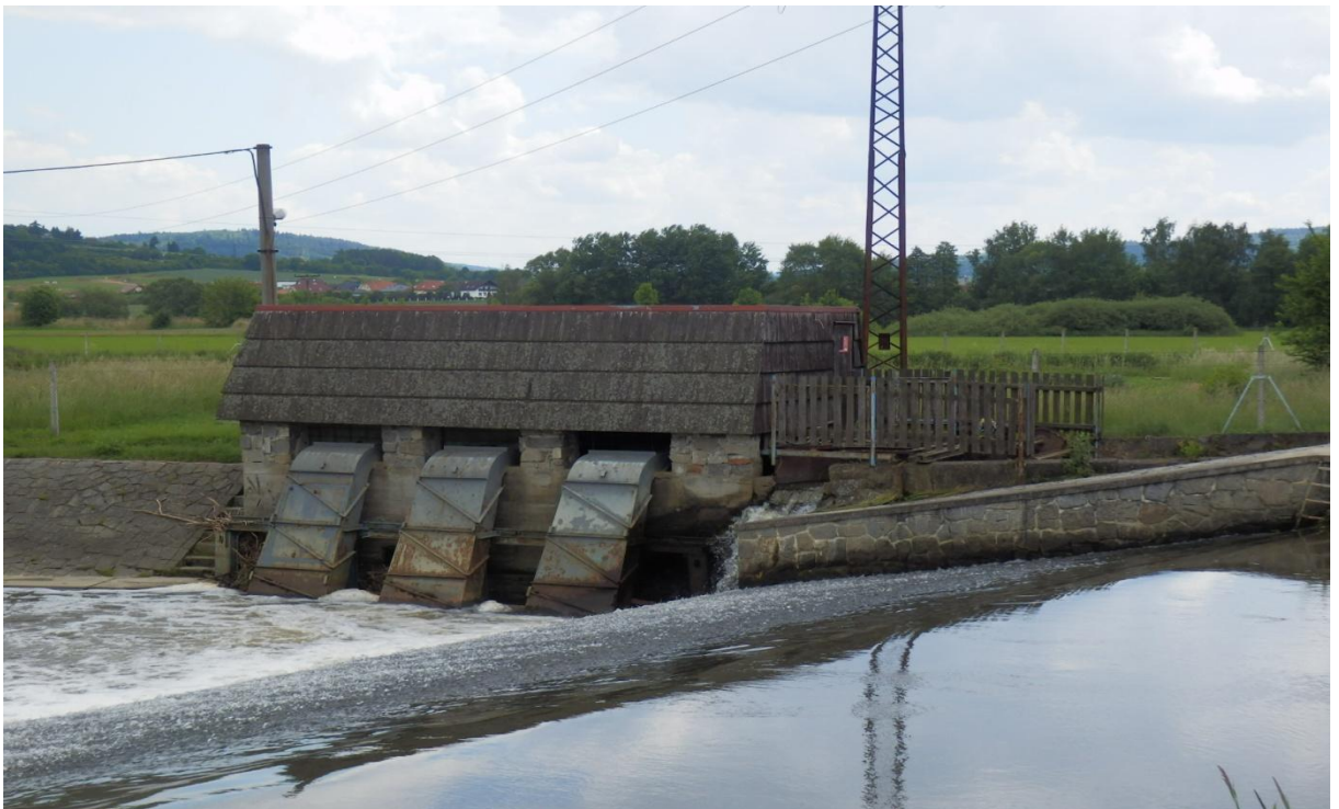
Obr. 4 – MVE v Přešticích na řece Úhlavě
