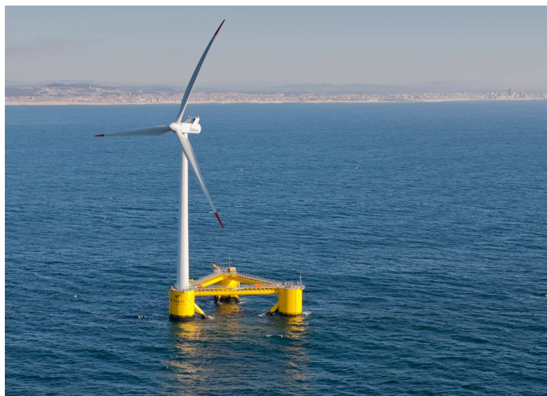
Obr. 2.5 Plovoucí větrná elektrárna typu WindFloat [22]
