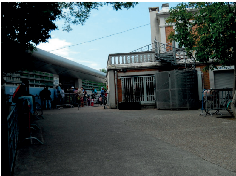
Obr. č. 3 Pohled do dvora Ramier – vlevo jídelna, vpravo sprchy
