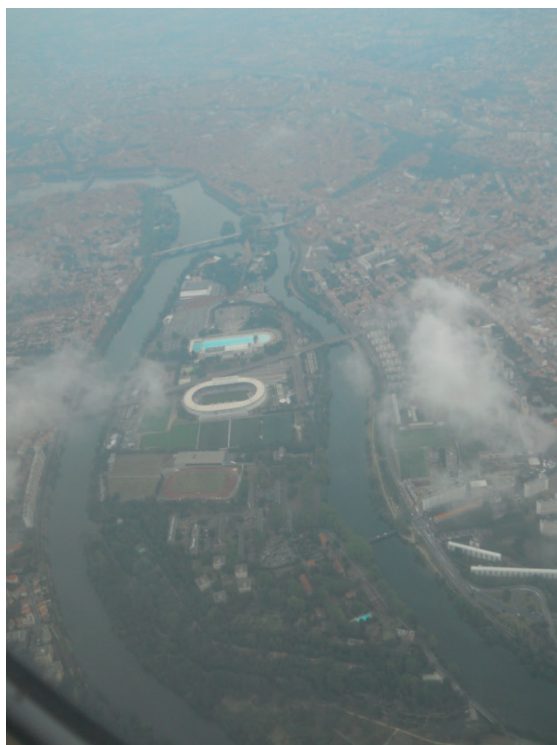
Obr. č. 1: Letecký pohled na ostrov Ramier
