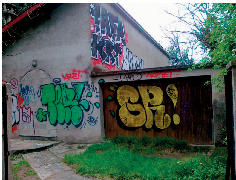
Obr. č. 14.: Zabetonovaný squat - jaro 2014
