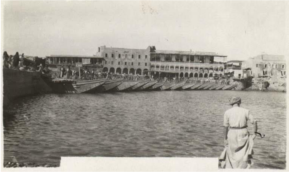
Obr. č. 8. Most z lodí (celkový pohled).
