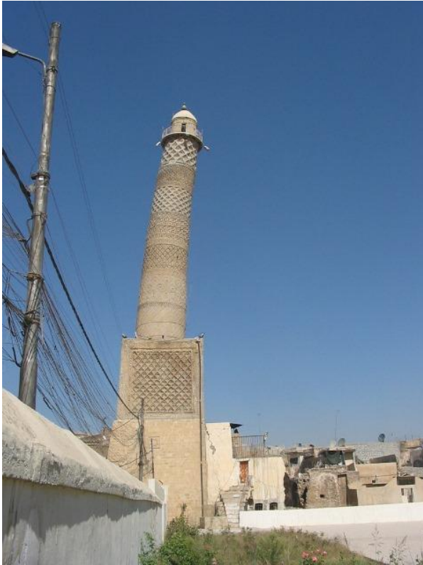
Obr. č. 14. Minaret al-Hadba.
