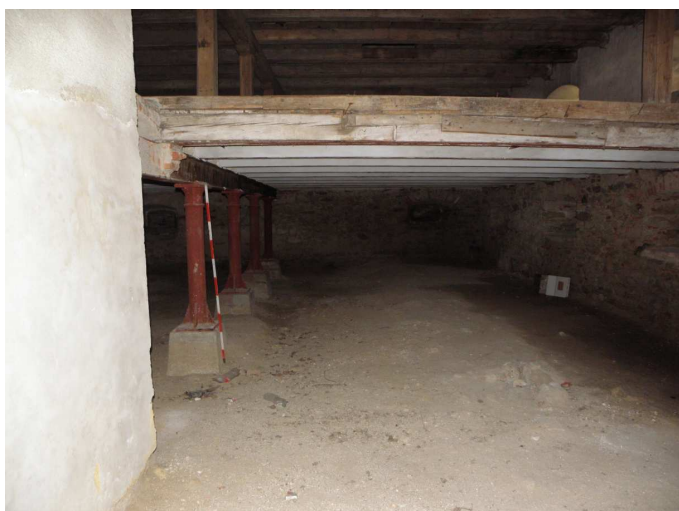
Obr. 30 Pohled do západního křídla
