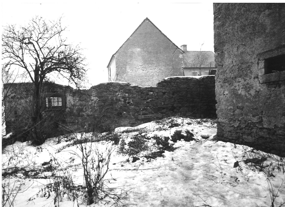
Obr. 13 destruované stavení č. p. 3.
