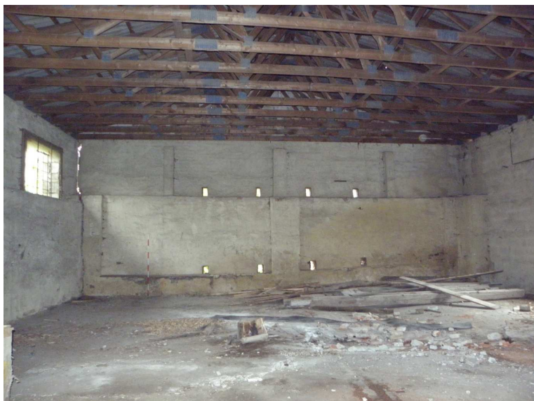
Obr. 38 jižní štít východní stavby. Pohled z interiéru
