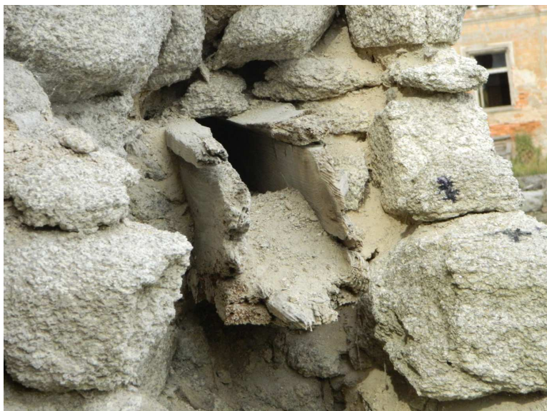
Obr. 26 detail dřevěné výztuže ve východním štítu severní stavby
