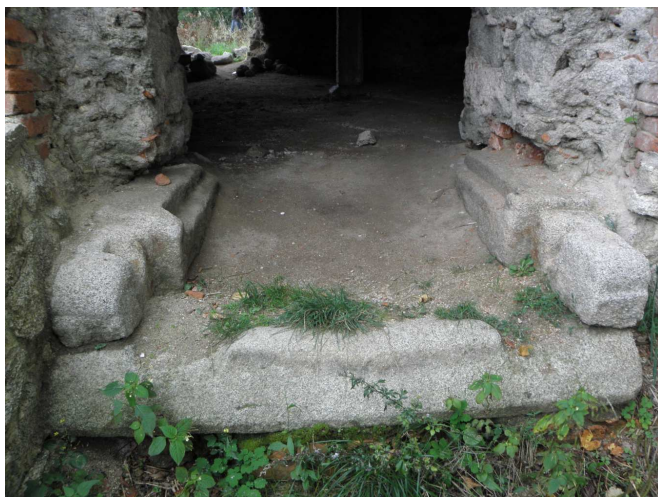
Obr. 29 ložisko pro padací most v severní stavbě hradního jádra
