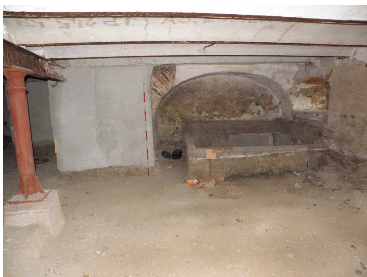
Obr. 31 náduvník v jihovýchodním rohu západního křídla
