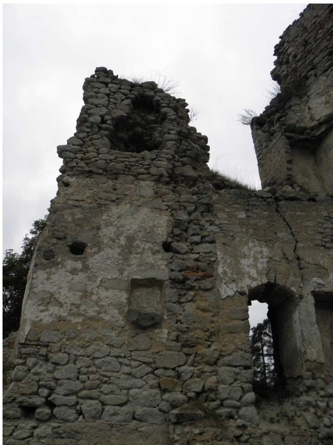
Obr. 24 Detail jižní zdi a lavaba ve východním traktu
