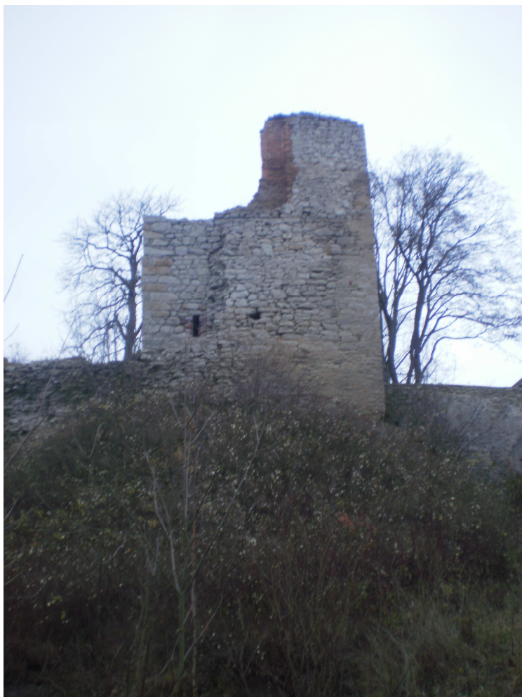
Obr. 44 východní štít z příkopu. Ve zdivu první je viditelná špaleta kopírující hranu cihlového ostění okna z druhé fáze.
