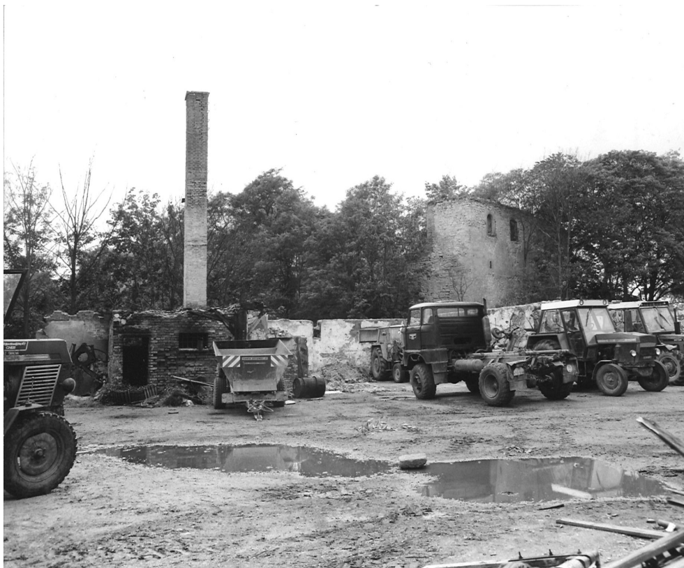
Obr. 14 vyhořelý hospodářský objekt na jižní straně předhradí
