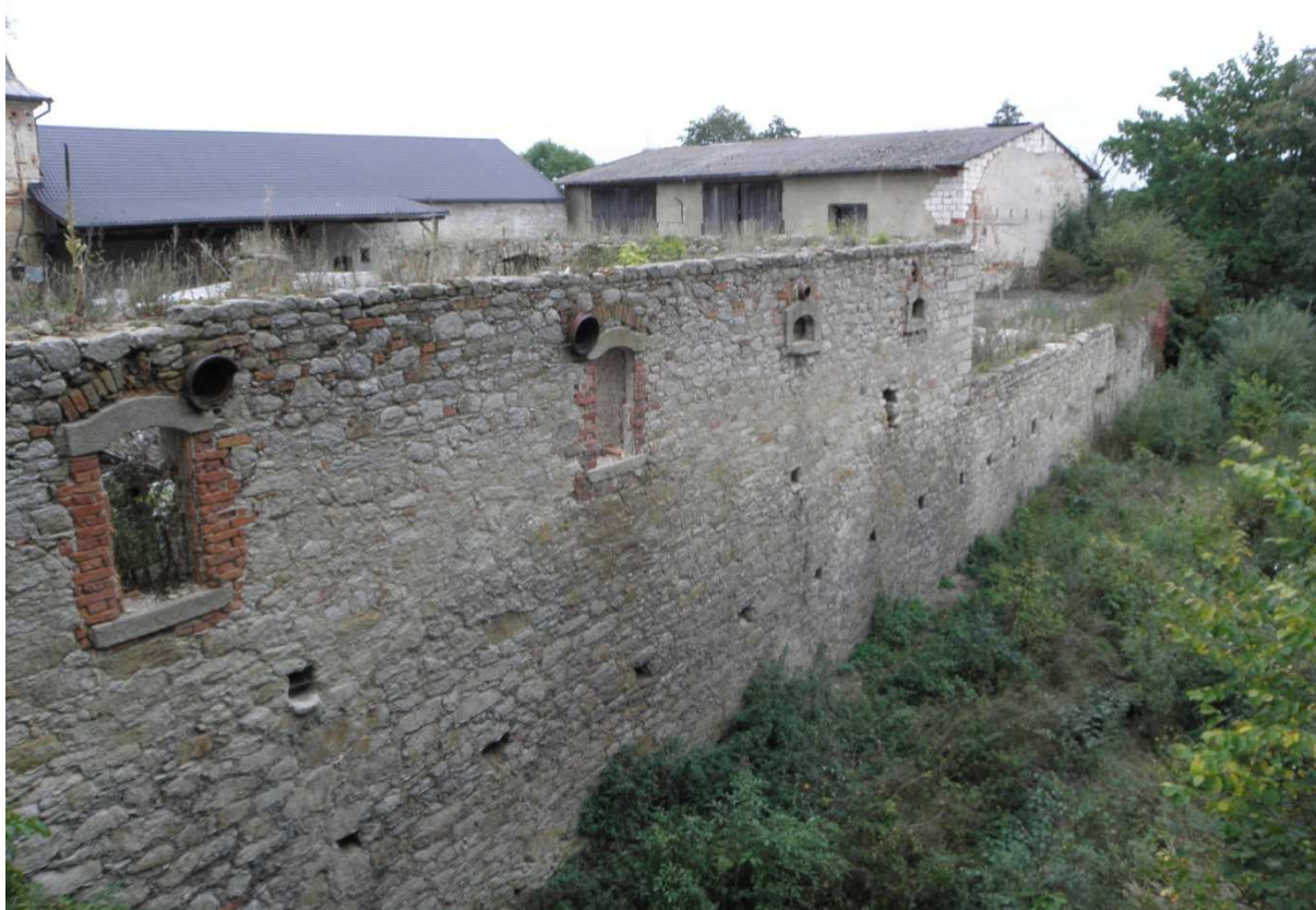
Obr. 17 Pohled z hradního jádra. Na východní straně hospodářský objekt z obr. 10,11 a14. Negativy původní stavby jsou čitelné na východním štítu, který umožňuje přehlednou stratigrafickou analýzu.
