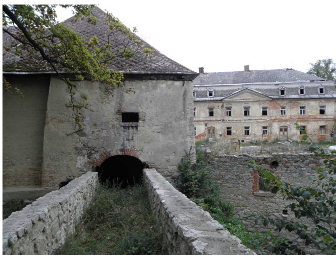
Obr 27 portál vstupu na most
