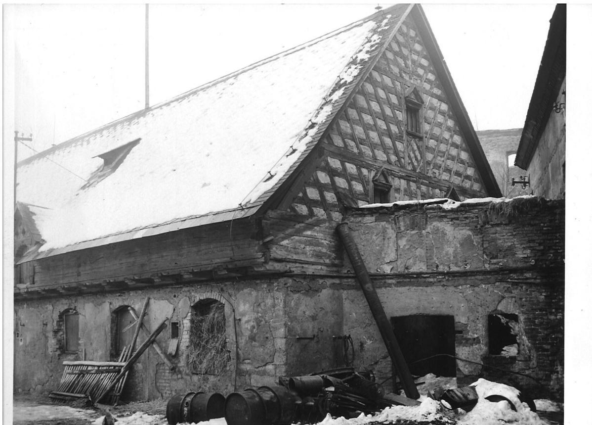
Obr. 10 Destruované stavení na jižní straně (rok 1970)
