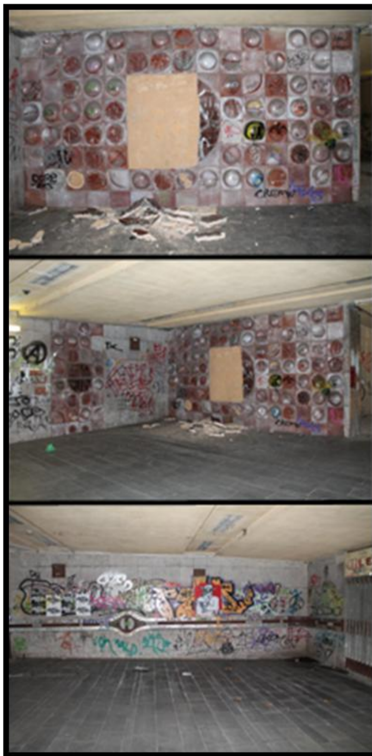
Keramické reliéfy – podchod v Tylově ulici (odstraněno roku 2014)
