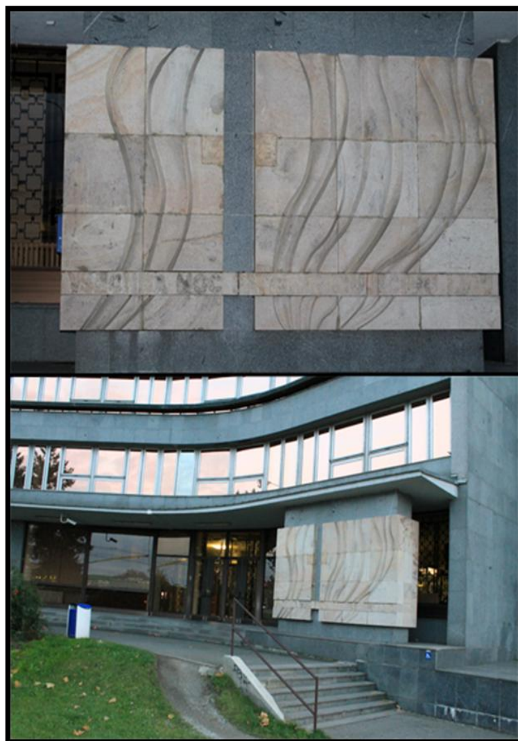
Reliéfni stěna – Pražská ulice
