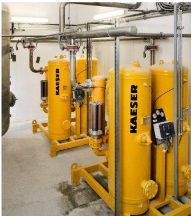
Obrázek č. 4.14 Adsorpční sušiče vzduchu DC 266E
