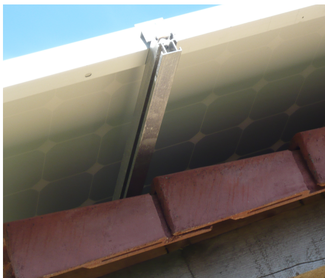
Obrázek 9: Hliníkový profil nosné konstrukce modulů
