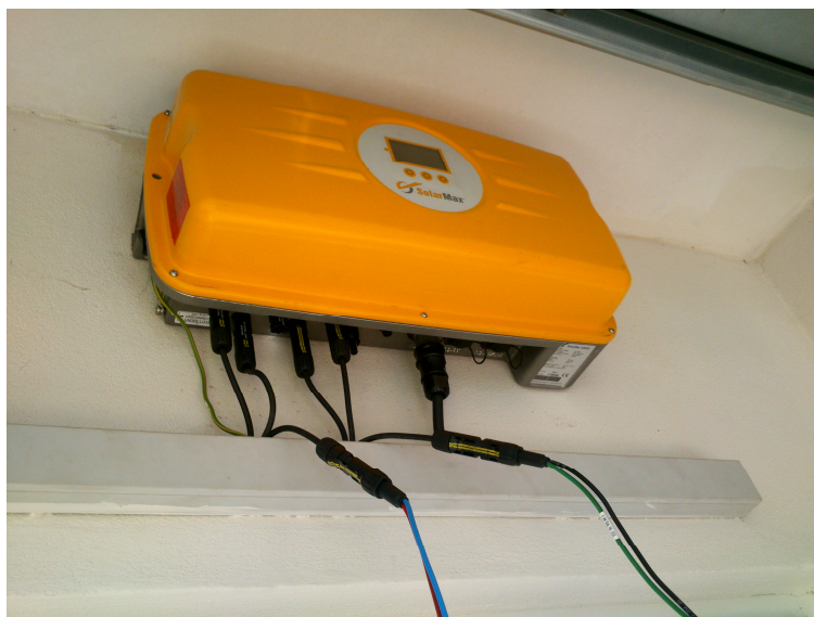
Obrázek 28: Měření V-A charakteristiky jednoho stringu z FVE
