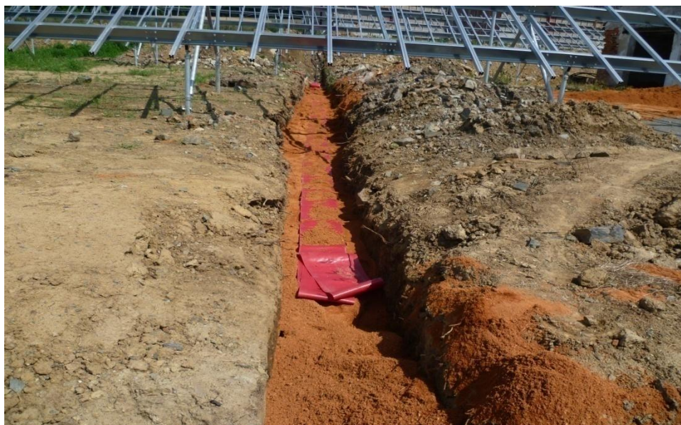
Obrázek 7: Příklad uložení AC kabeláže v pískovém loži s ochrannou folií, nad kabeláží je vidět holá nosná konstrukce připravená na osazení panely.
