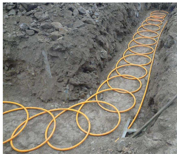
Obr. 10 – Uložení do šroubovice [Zdroj: 8]
