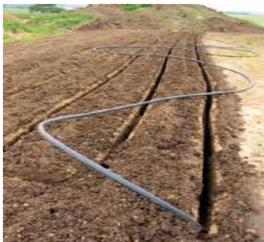
Obr. 9 – Meandrovité uložení [Zdroj: 7]
