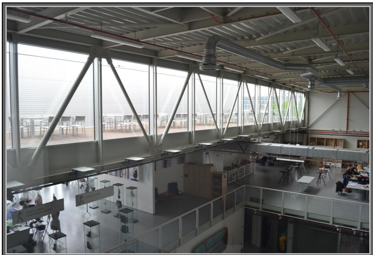
Obrázek 39 Osvětlení objektu je řešeno pomocí klasických zářivek a prosklených terasových částí střechy [39o]
