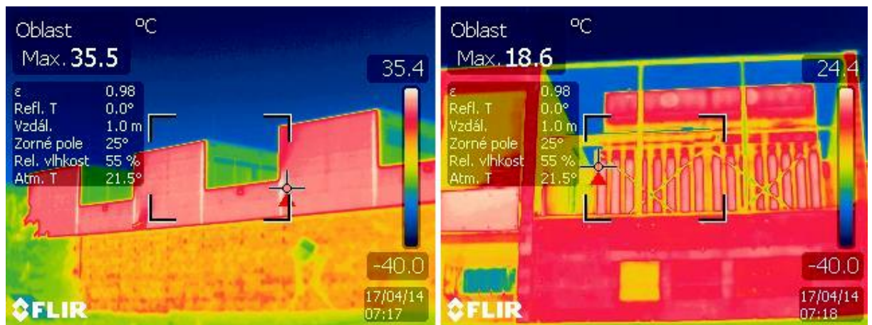
Obrázek 27 Vlevo zadní strana pláště budovy a vpravo chladicí věž na střeše fakulty [27o]
