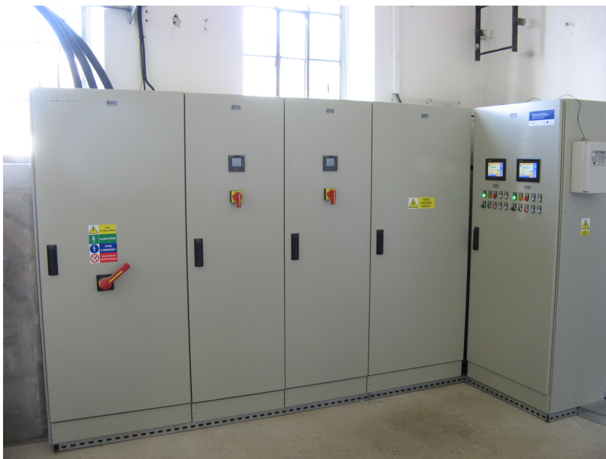
Obrázek 8 – Nové elektrorozvaděče.
