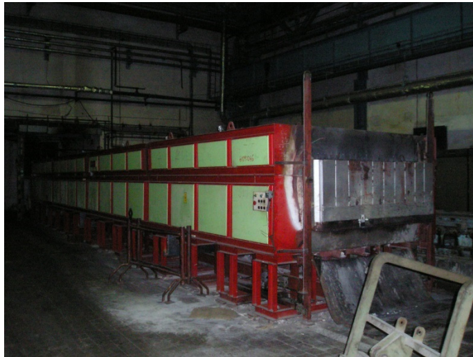
obr.č.12.: Elektrická pec FORNAX pro ohřívání čepů před válcováním
