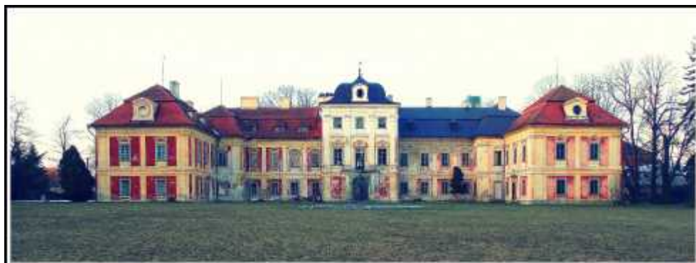
Barokní zámek v Dolní Lukavici Pohled ze zámeckého parku, jižní strana
