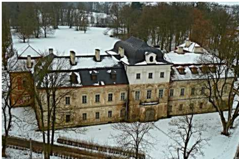
Severní strana lukavického zámku
