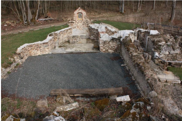
Obr. 56: Kostelní loď, pohled z věže
