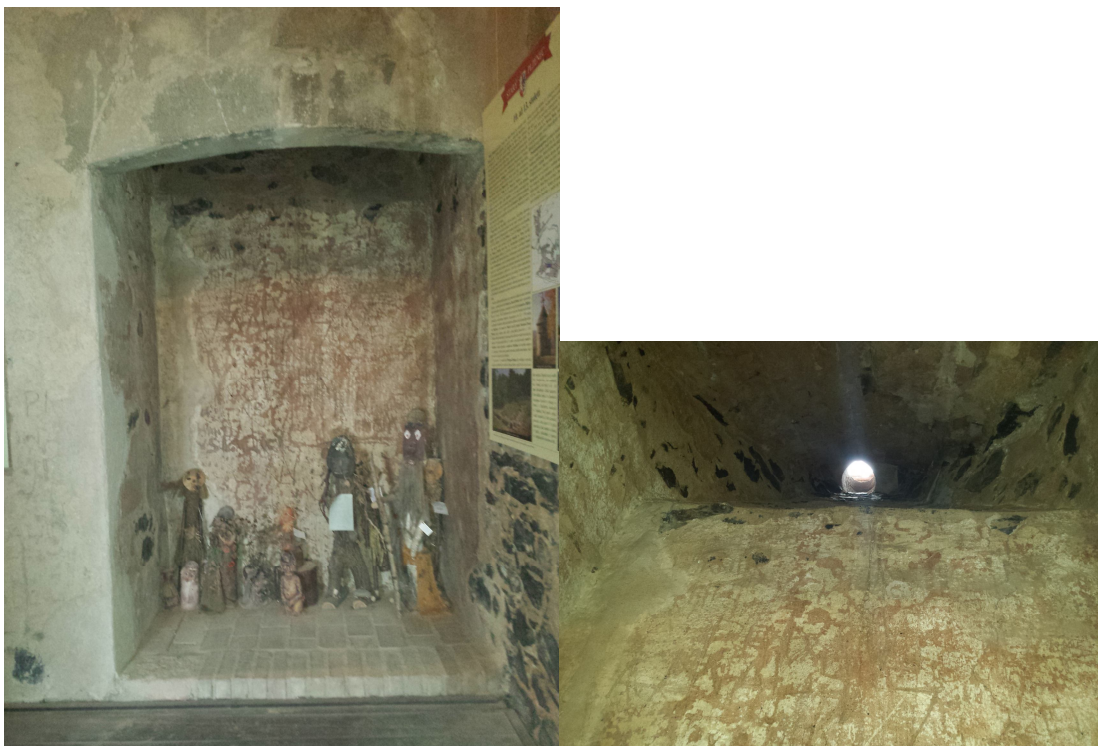
Obr. 18: Radyně. Krbový výklenek v 2. podlaží čtverhranné věže, detail kuřovodu, jihozápadní nároží.
