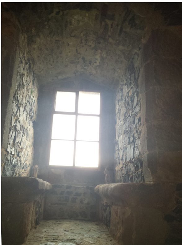
Obr. 10: Radyně. Obdélné okno se sediliemi ve 4. patře čtverhranné věže, východní strana.
