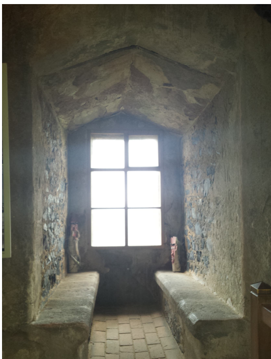
Obr. 19: Radyně. Rozměrné okno se sediliemi a segmentovým záklenkem 2. podlaží čtverhranné věže, jižní strana.
