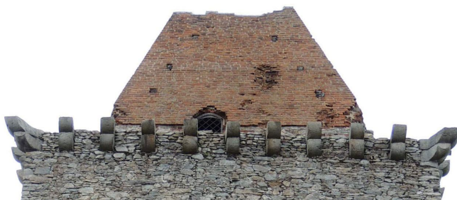
Obr. 27: Kašperk. Pohled na krakorce západní a východní věže.
