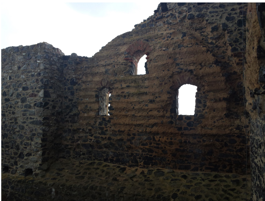
Obr. 15: Radyně. Detail pozůstatku roubené komory v 2. poschodí paláce při čtverhranné věži.
