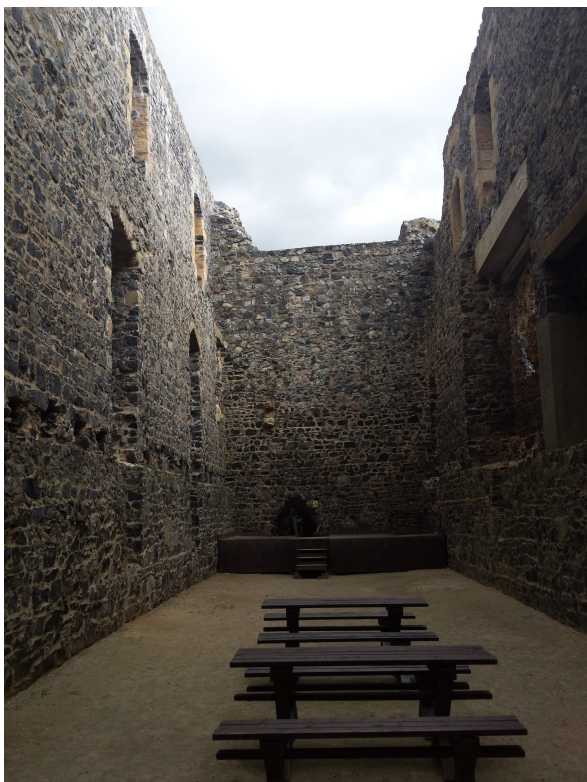
Obr. 11: Radyně. Pohled na polookrouhlou věž hradu od čtverhranné věže.
