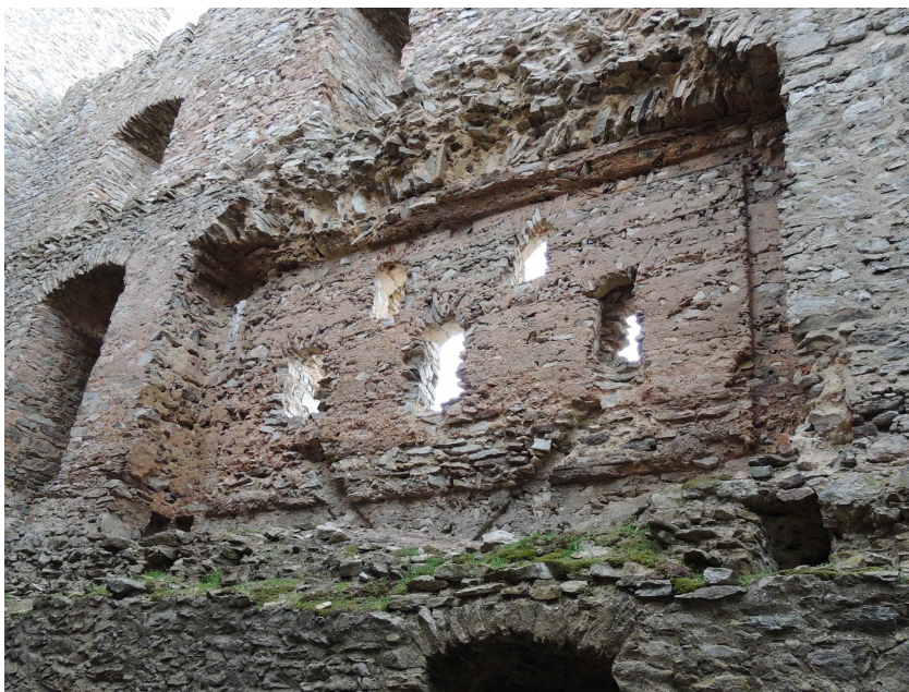
Obr. 29: Kašperk. Pozůstatek po roubené komoře, 5 okének v 2. podlaží paláce.
