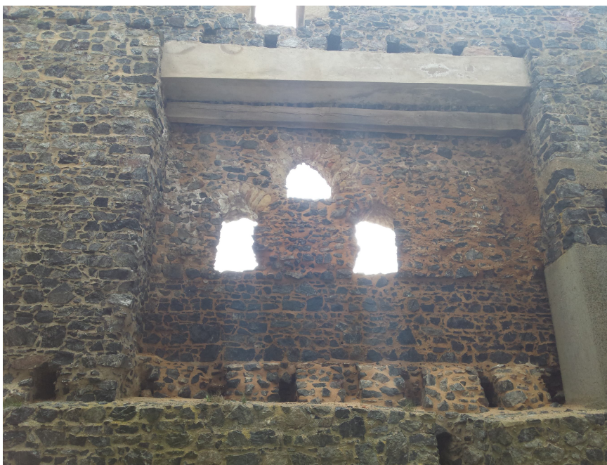
Obr. 14: Radyně. Tři okenní otvory v 1. poschodí paláce, pozůstatek roubené komory, viditelná novodobá betonová podpěra a kapsy po trámech.
