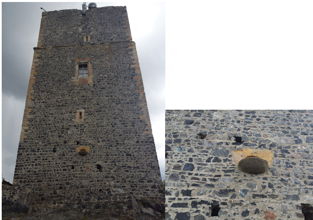
Obr. 8: Radyně. Pohled na čtverhrannou věž z místa cisterny, detail výlevky.
