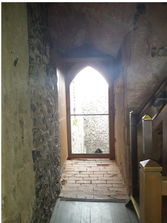
Obr. 22: Radyně. Portál s jednoduše okoseným ostěním, severní strana čtverhranné věže.
