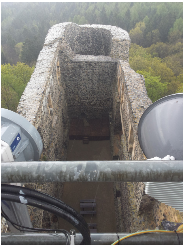
Obr. 20: Radyně. Pohled z vyhlídkového patra čtverhranné věže na palác a polookrouhlou věž.
