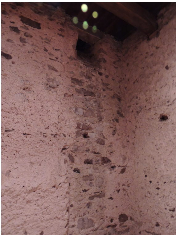
Obr. 34: Kašperk. Komín v severní zdi západní věže z černé kuchyně.
