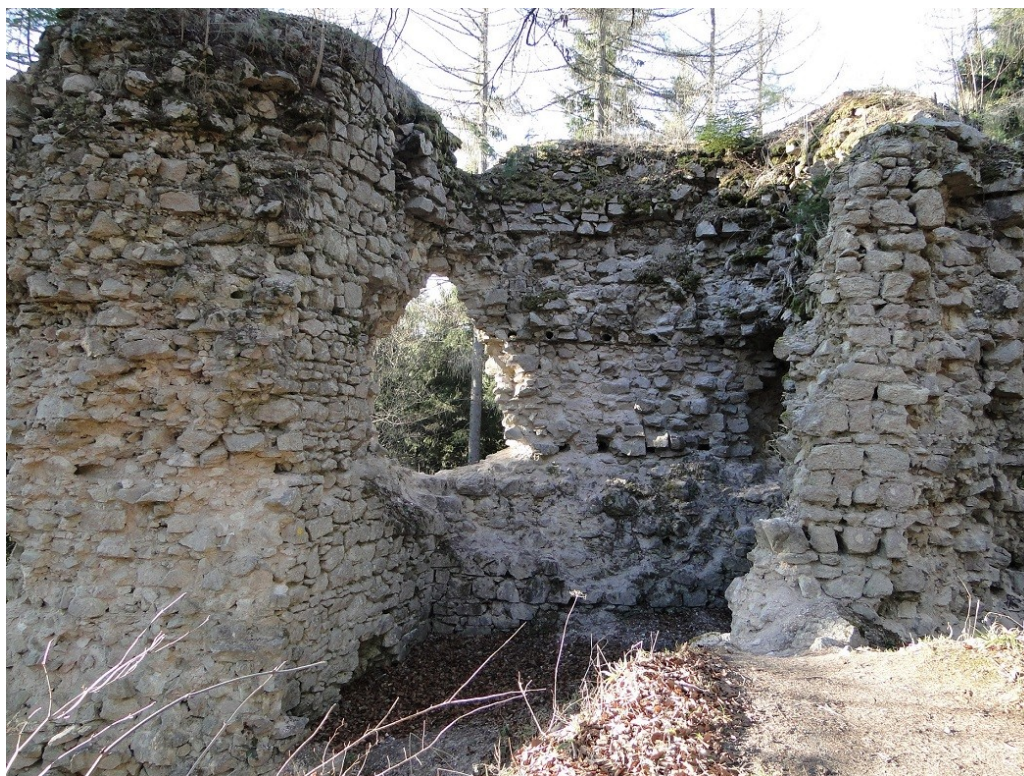
Obr. 37: Interiér púlválcové věže.
