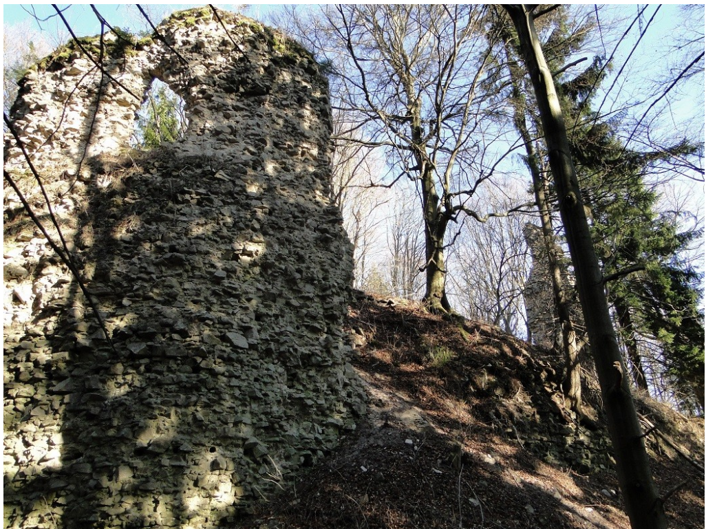
Obr. 36: Bašta v severozápadním nároží.
