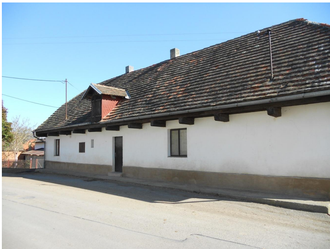
Obr. č. 9: Dům čp. 2 - dříve obecní pastouška
