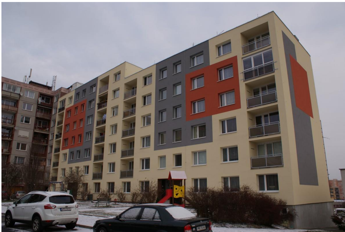
Obr. č. 2 Zrekonstruovaný panelový dům v Plzni na Lochotíně, 2015
